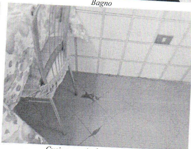
Cucina, particolare pavimento
