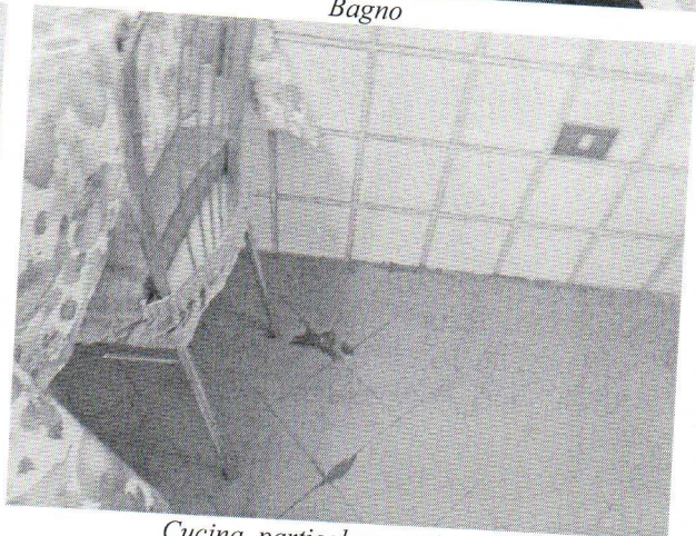
Cucina, particolare pavimento
