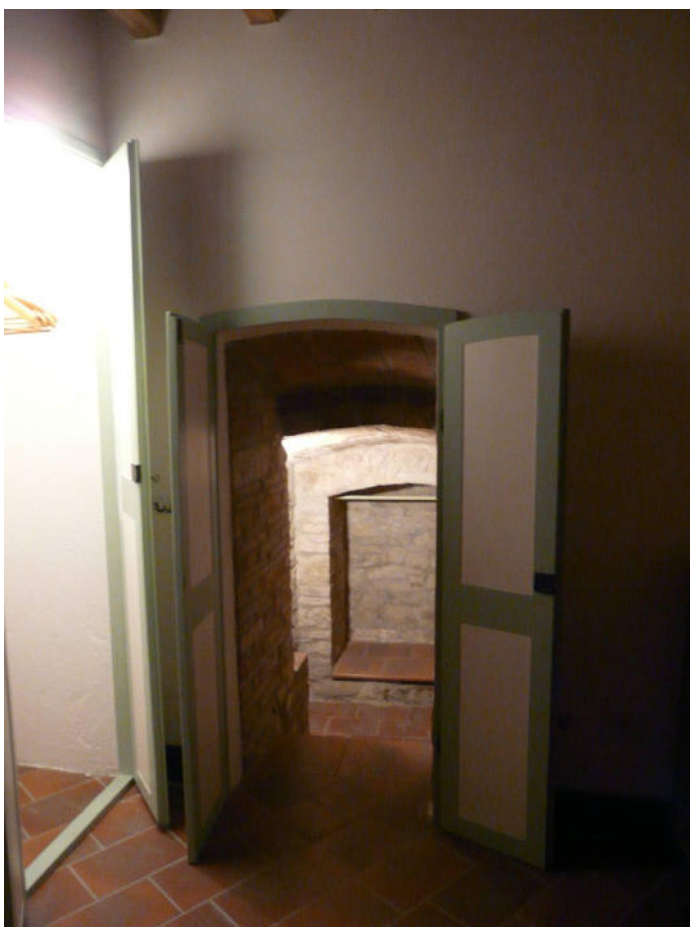
Foto 10- Vista del ripostiglio sottoscala e del locale interrato
