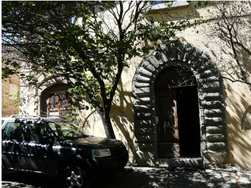
Foto 1 – Vista dell'ingresso da Piazza Pignattaria
