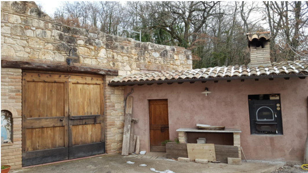
Foto 12 – Ingresso del garage (sub. 4) e della legnaia
