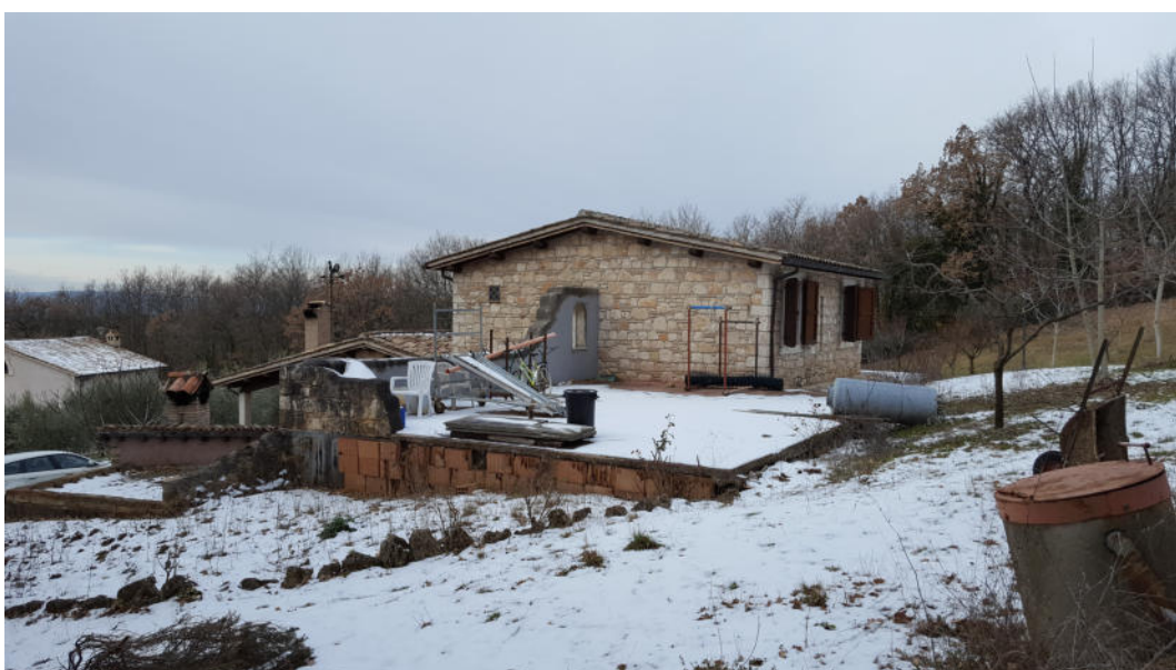
Foto 3 – Vista da est
