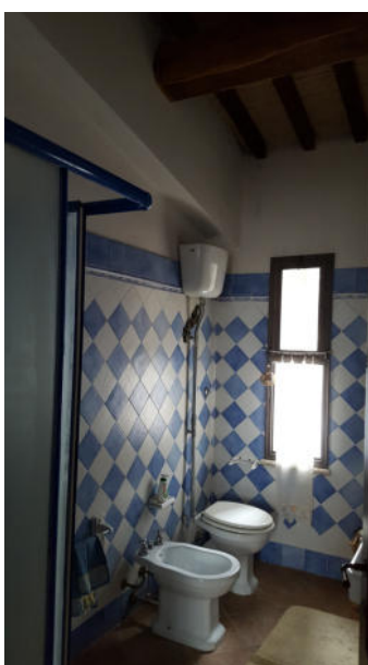
Foto 10 – Bagno al piano primo
