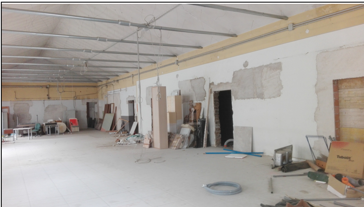
Illustrazione 8: porzione in ristrutturazione
