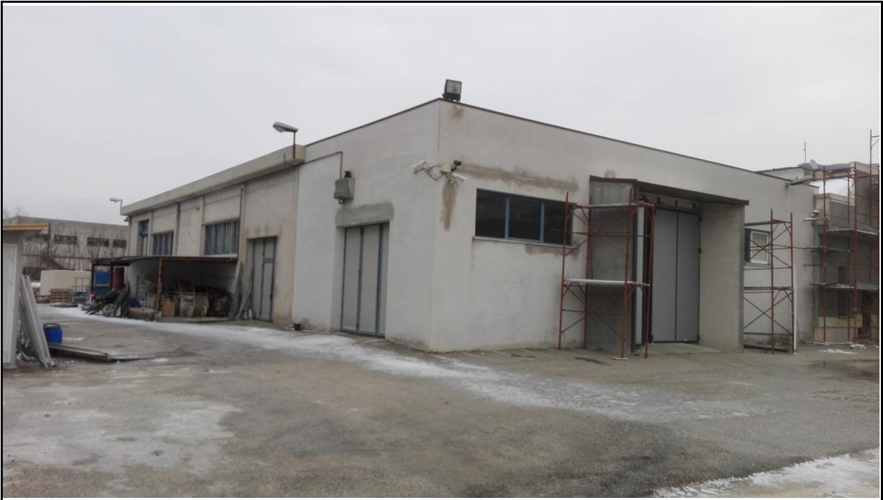
Illustrazione 4: vista sud-ovest capannone p.lla n.992
