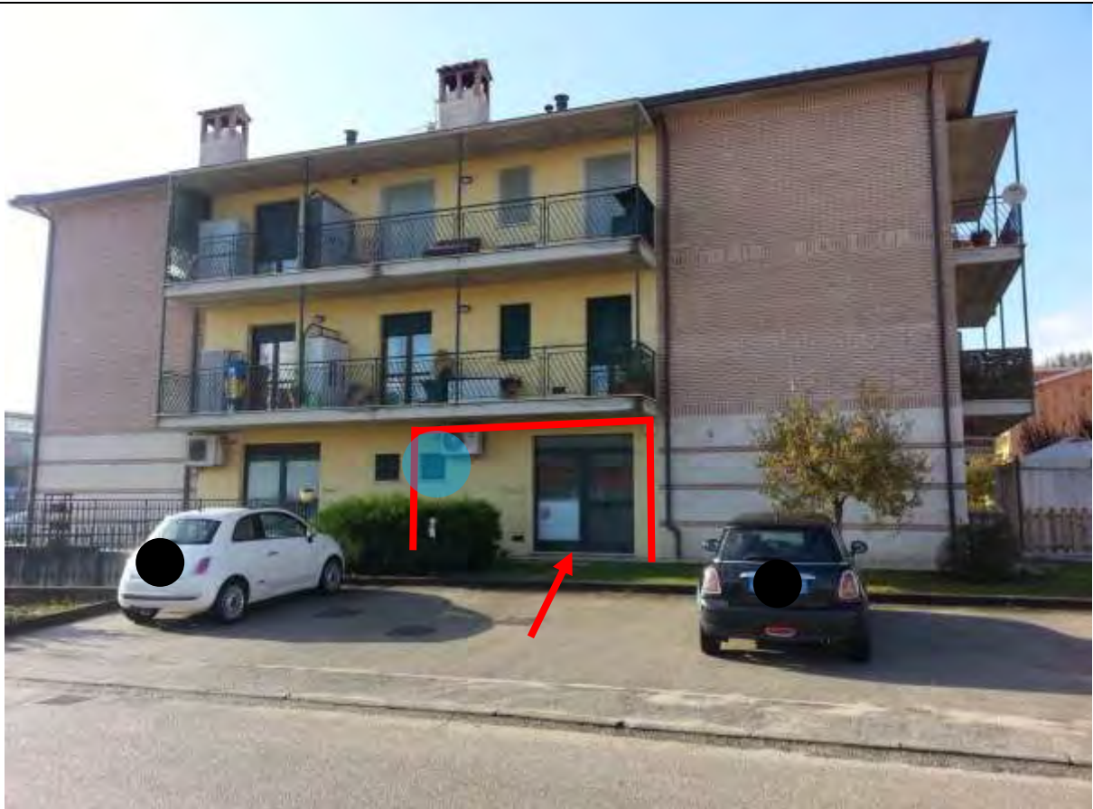
Foto 4 – Fronte laterale dell'edificio. In ROSSO il limite dell'unità immobiliare pignorata posta al piano terra e l'ingresso sulla strada. Si evidenzia la finestrella alta del bagno.
