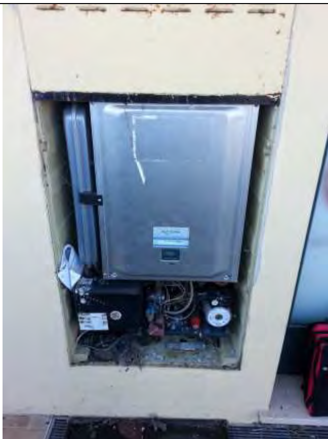
Foto 27-28 – Particolare impianto di riscaldamento a convettori alimentati a gas metano con caldaia esterna.
