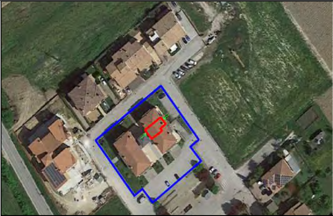
Foto 3 – In ROSSO la posizione dell'unità immobiliare pignorata (Sub. 36) all'interno dell'edificio. In VERDE la posizione dei due ingressi, quello sul fronte laterale comunicante con la strada esterna e quello sul lato interno opposto. In BLU l'area comune (Sub. 1 BCNC).
