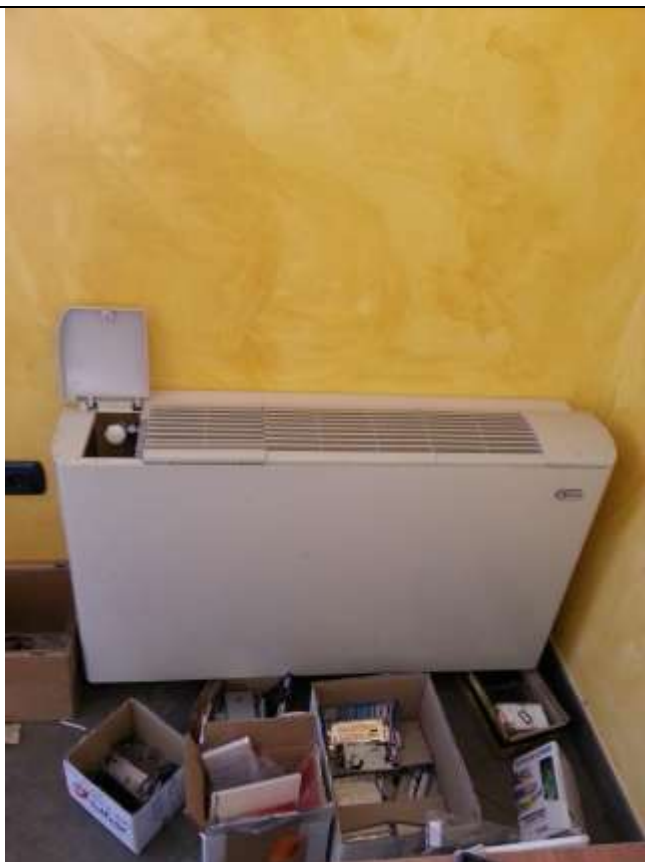
Foto 27-28 – Particolare impianto di riscaldamento a convettori alimentati a gas metano con caldaia esterna.
