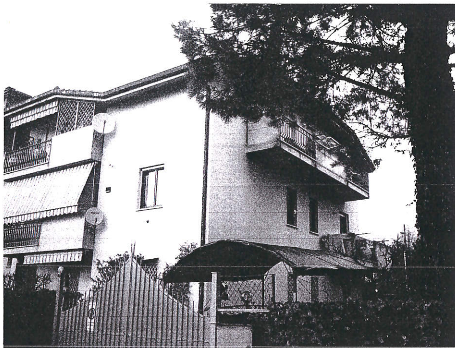
Foto n° 3: prospetto Sud del fabbricato
