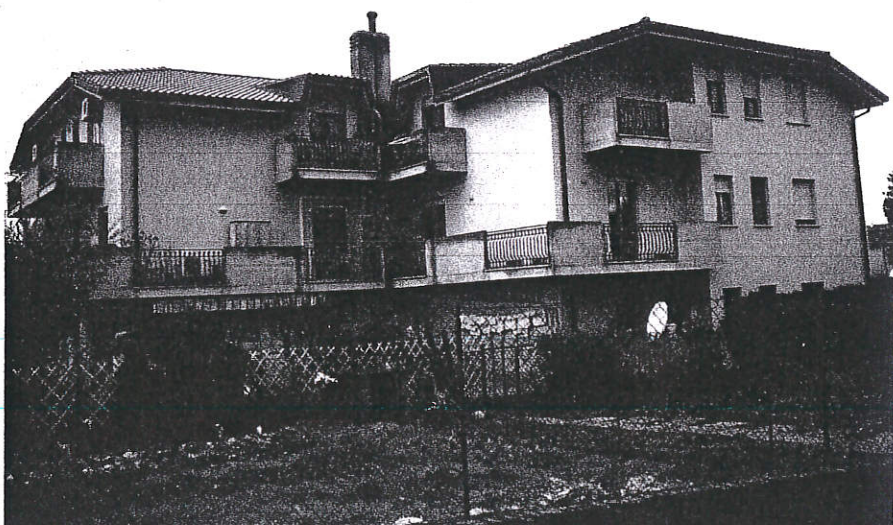
Foto n° 4: prospetto Est del fabbricato
