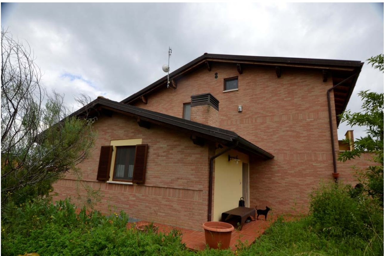
FOTO PROSPETTO FIANCO SINISTRO
