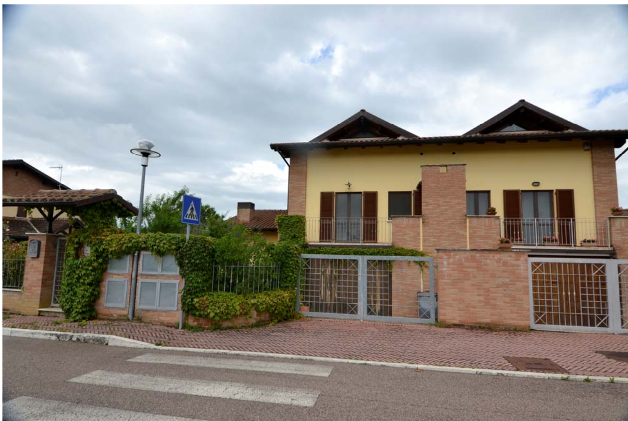
FOTO PROSPETTO FRONTALE
