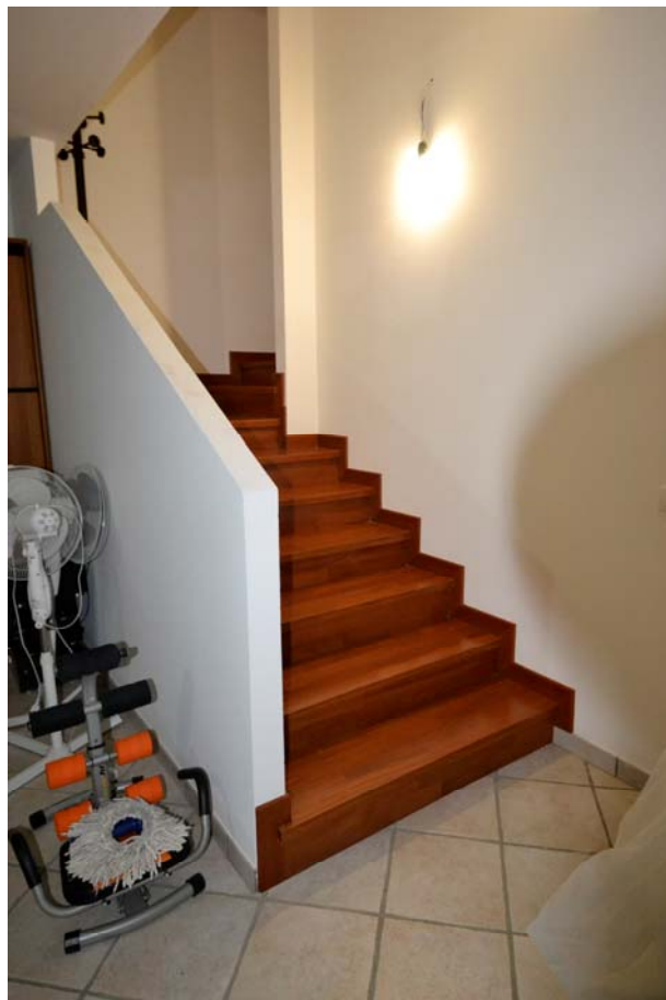
FOTO INTERNO SCALA ACCESSO DAL PIANO INTERRATO
