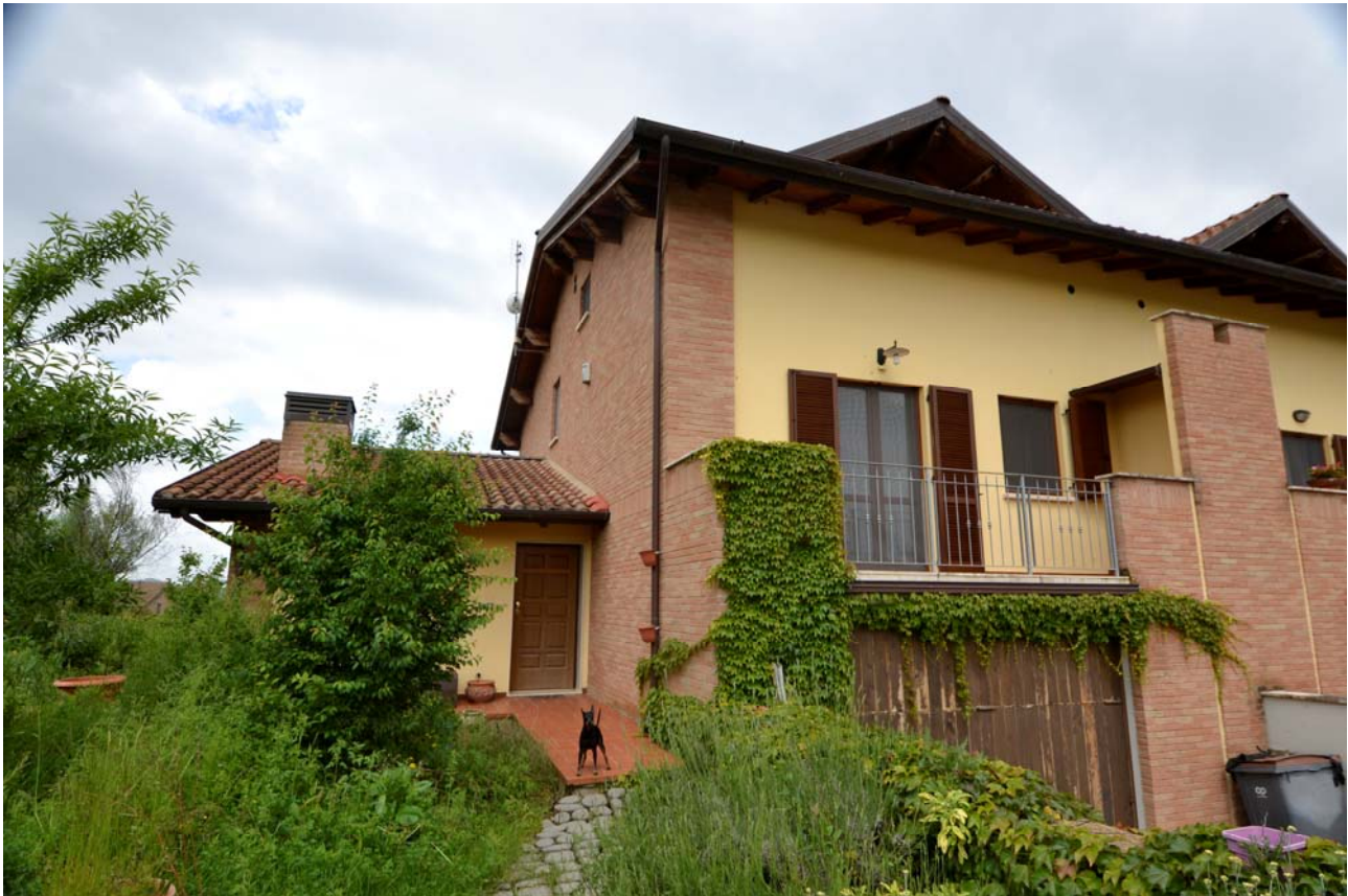
FOTO PROSPETTO FRONTE E FIANCO SINISTRO
