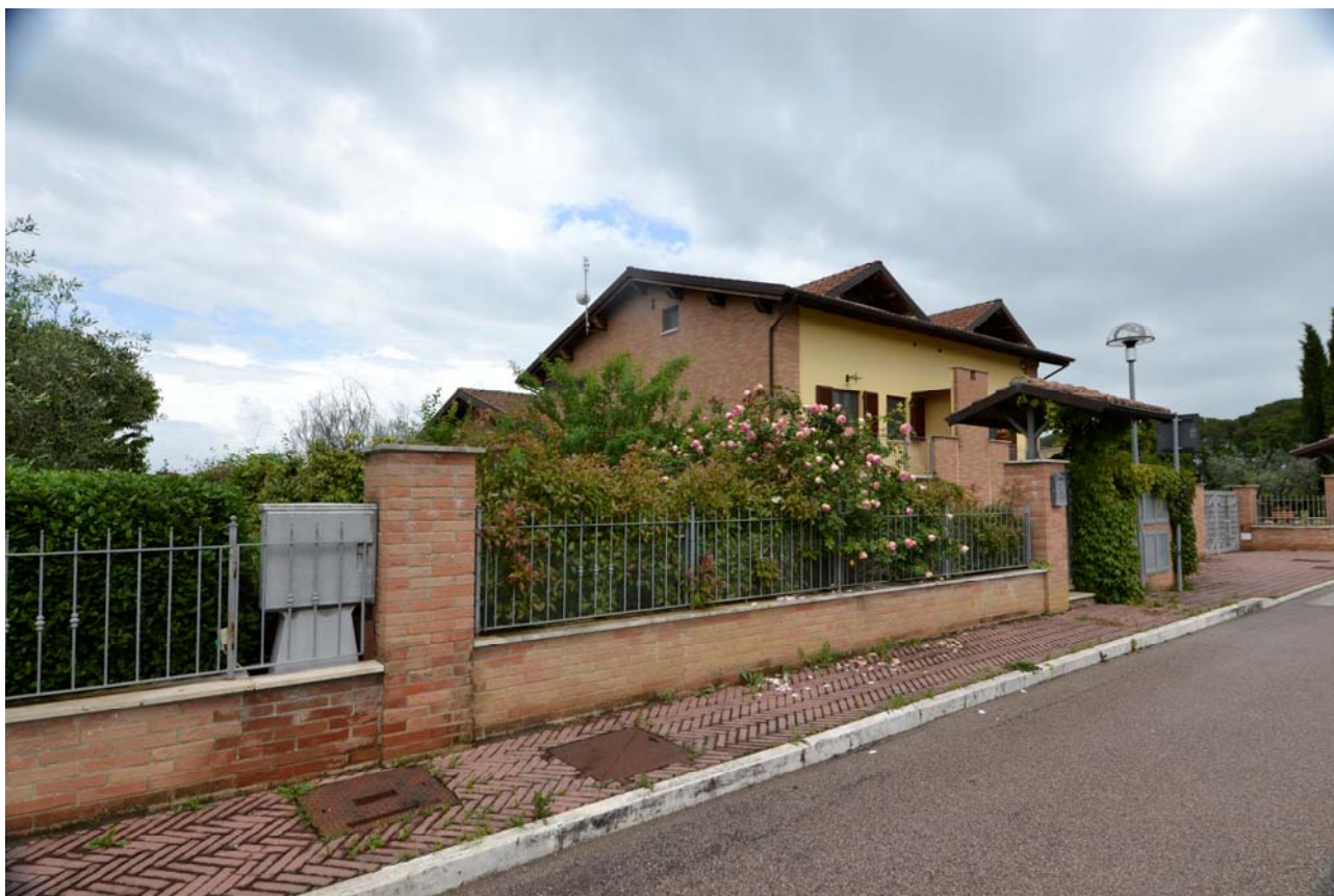
FOTO PROSPETTO FIANCO SINISTRO
