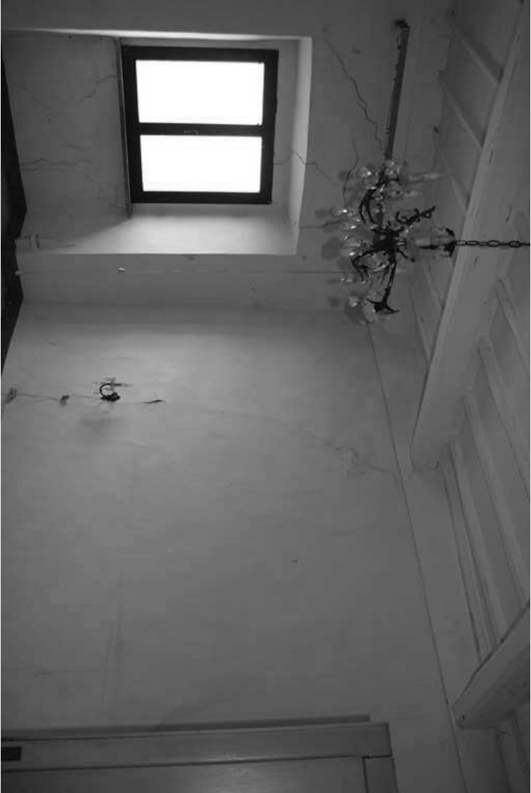
FOTO N° 5 Vista interna – locale di sgombero e bagno
