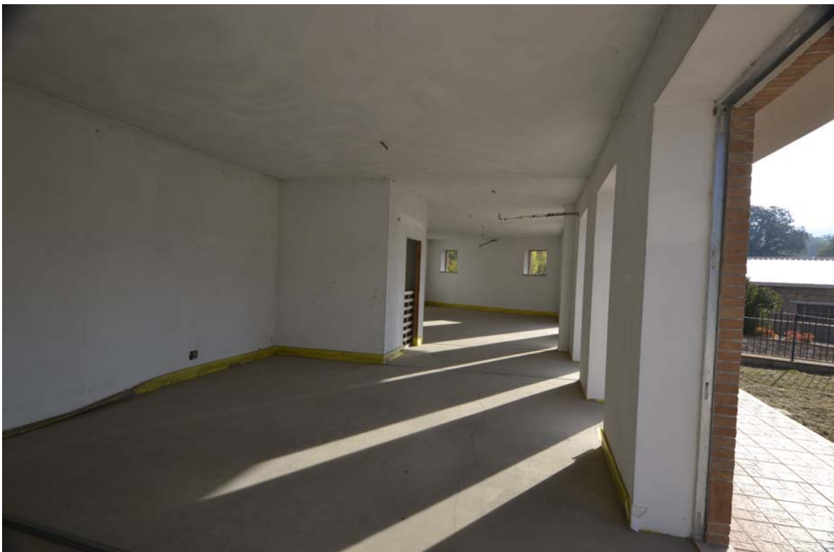
FOTO INTERNO NEGOZIO PIANO TERRA
