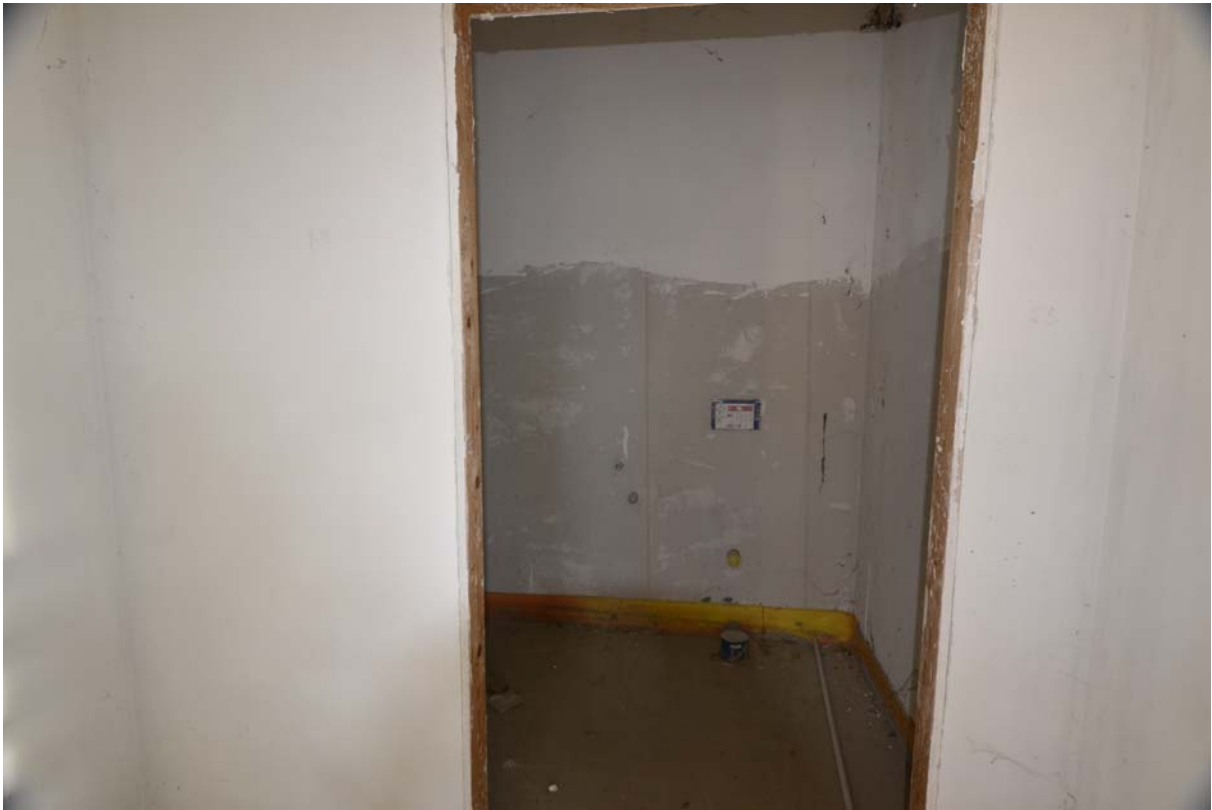
FOTO INTERNO BAGNO DEL NEGOZIO PIANO TERRA
