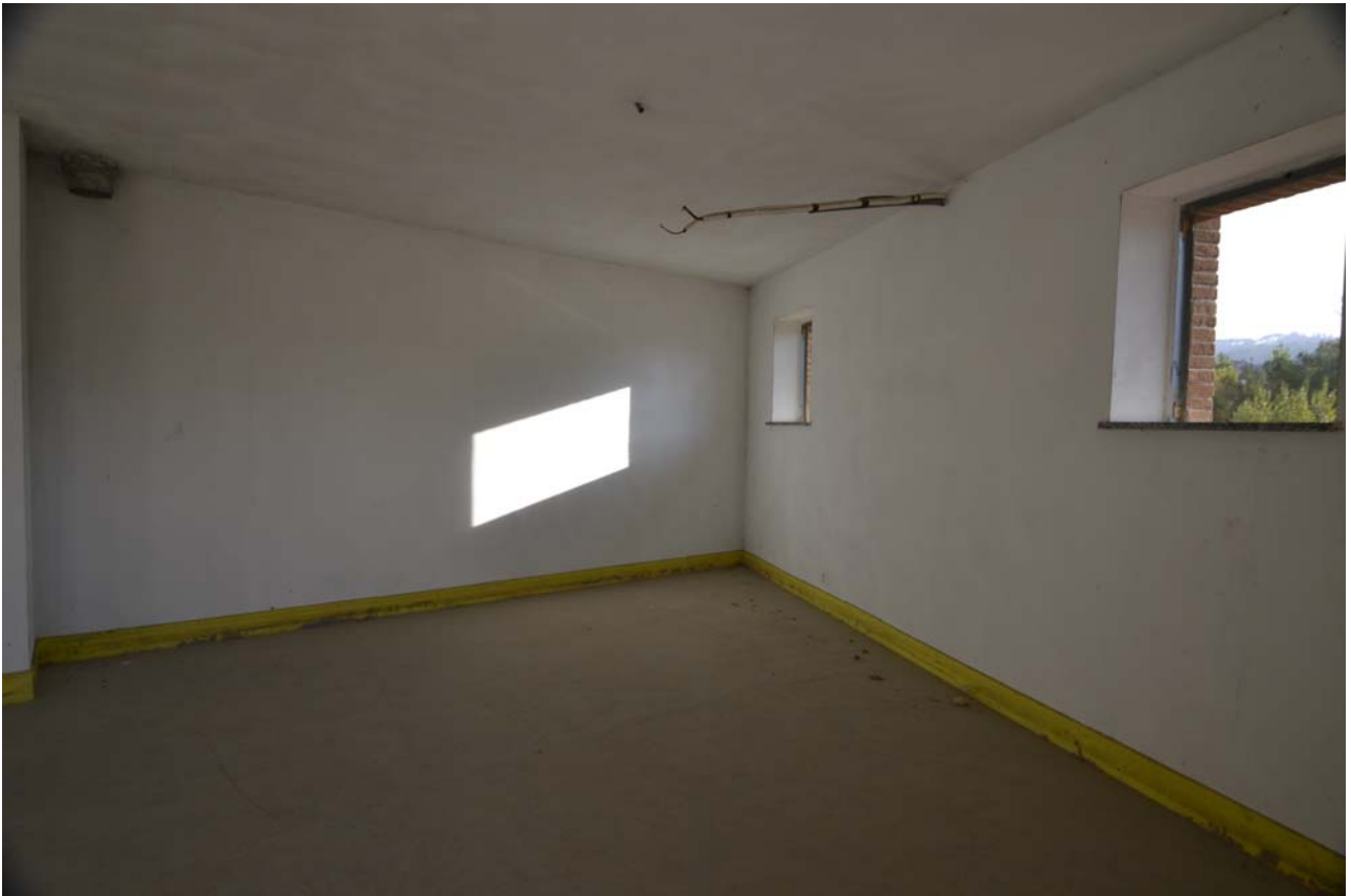
FOTO INTERNO NEGOZIO PIANO TERRA
