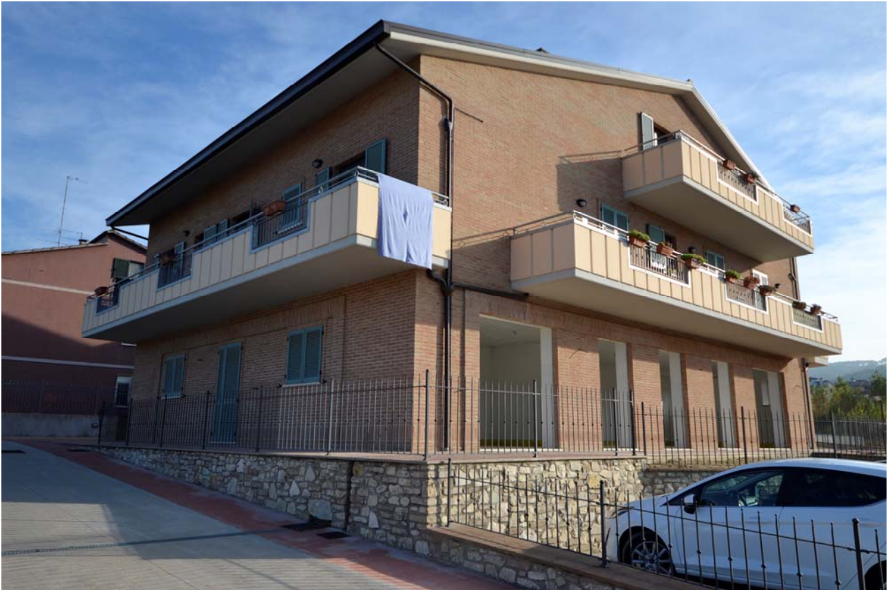
FOTO ESTERNO PROSPETTI FRONTE E FIANCO SINISTRO
