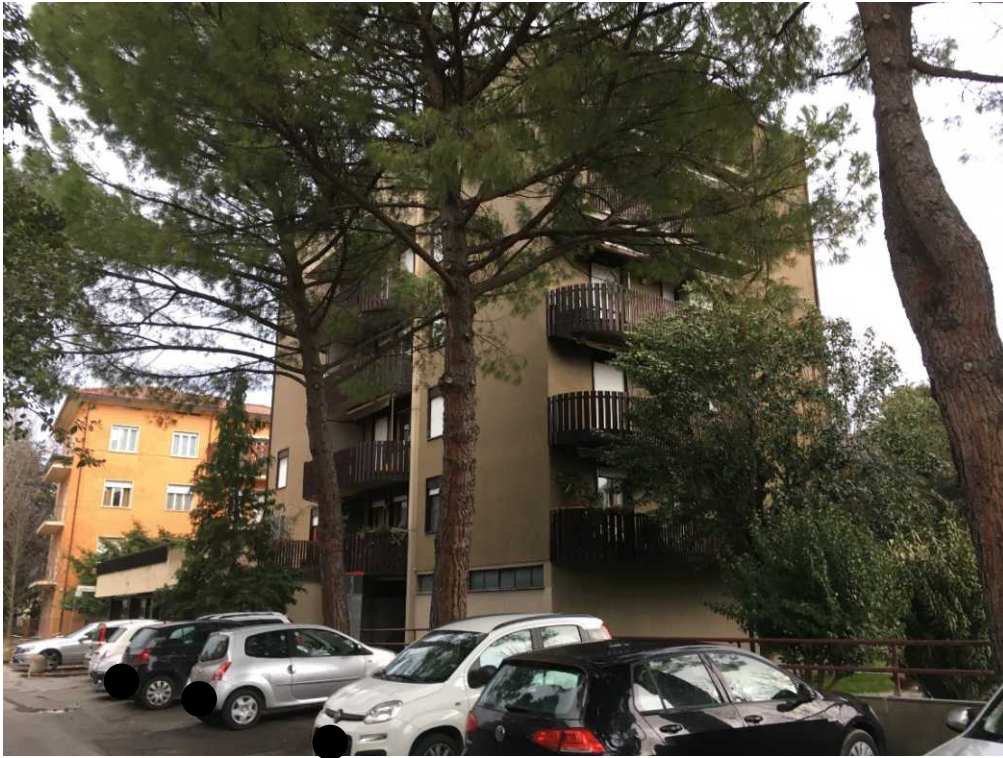
Foto 3 – Prospetto su Via Francesco Fazi
