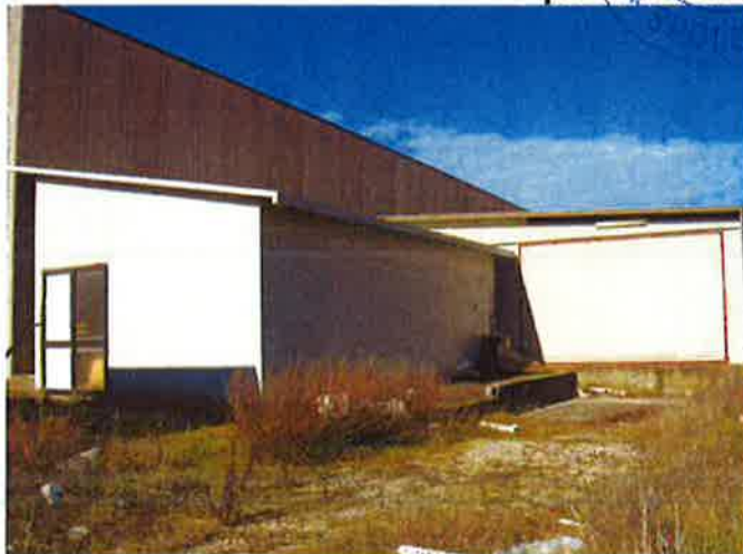
Vista esterna laterale dei fabbricati posteriori 2 e 1
