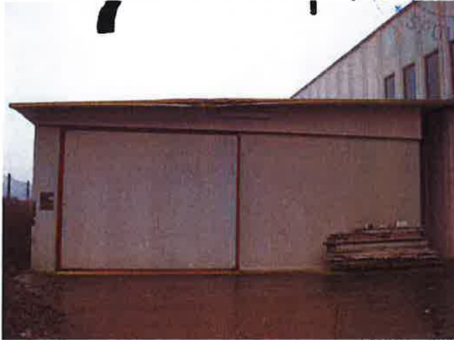
Vista esterna laterale del fabbricato posteriore 1
