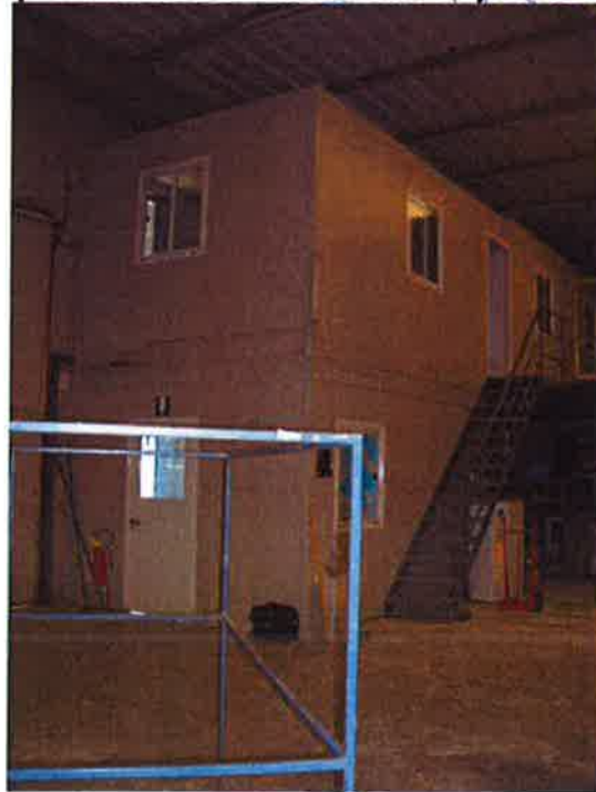
Il blocco prefabbricato interno che ospita la zona uffici
