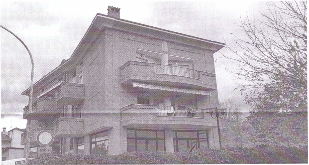
Foto 1 Esterno immobile sito in Marsciano tra via dello Sport n. 2 e via Gramsci, Fg 8, part 318.
