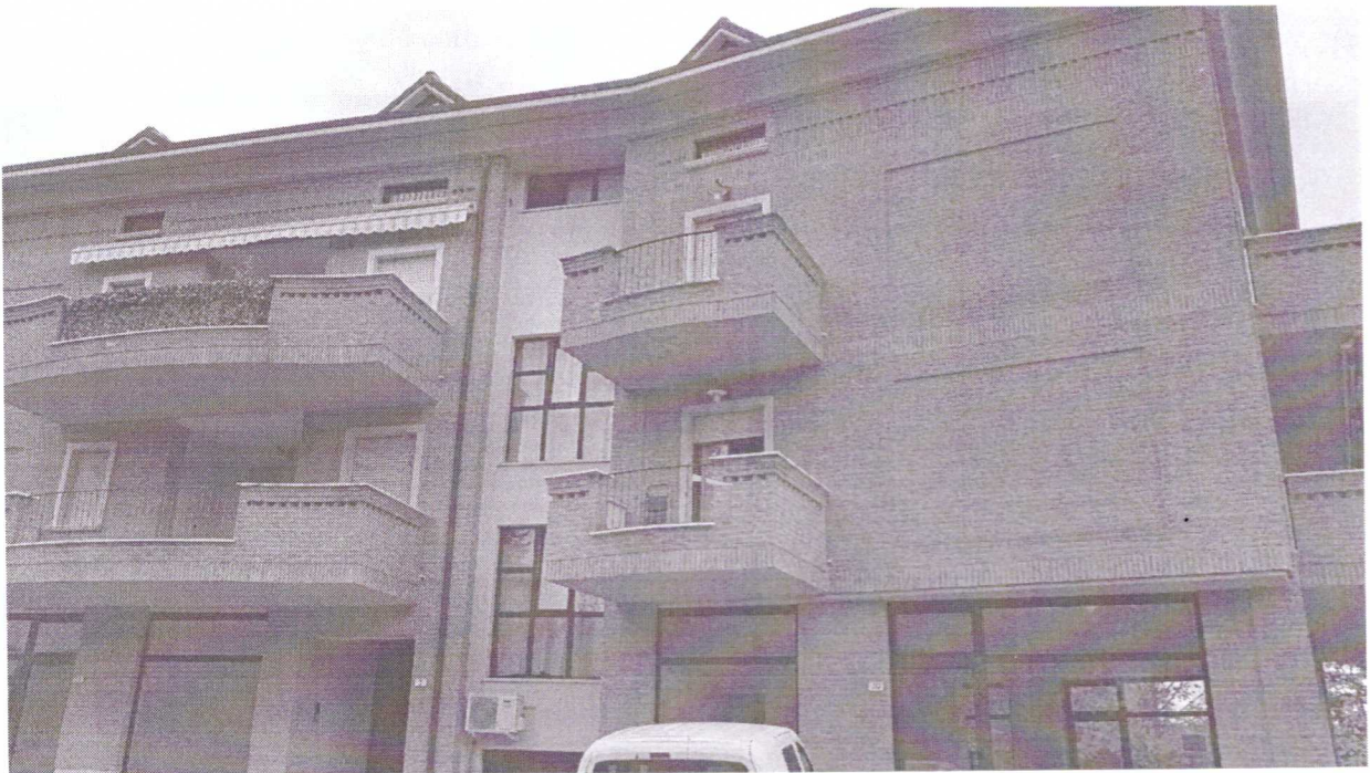
Foto 2 Esterno immobile sito in Marsciano tra via dello Sport n. 2 e via Gramsci, Fg 8, part 318.
