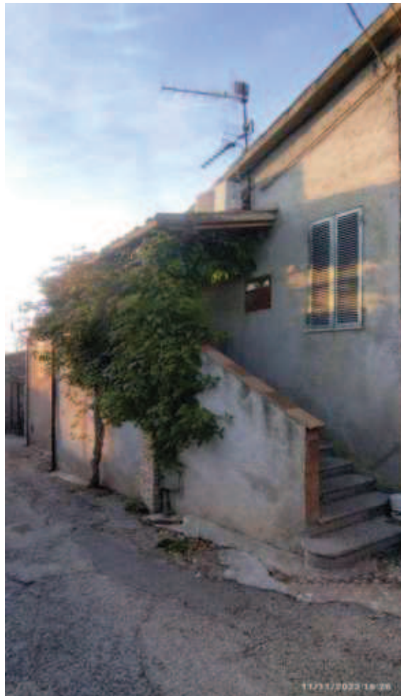
Ingresso Piano Primo
