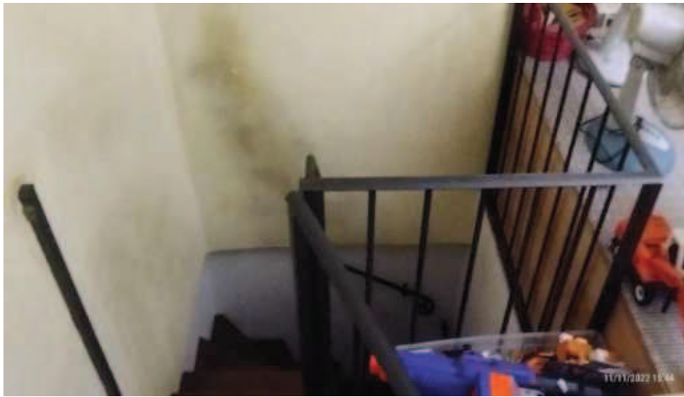
Scala al Piano Terra
