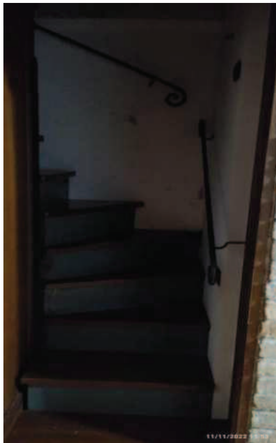
Scala al Piano Primo
