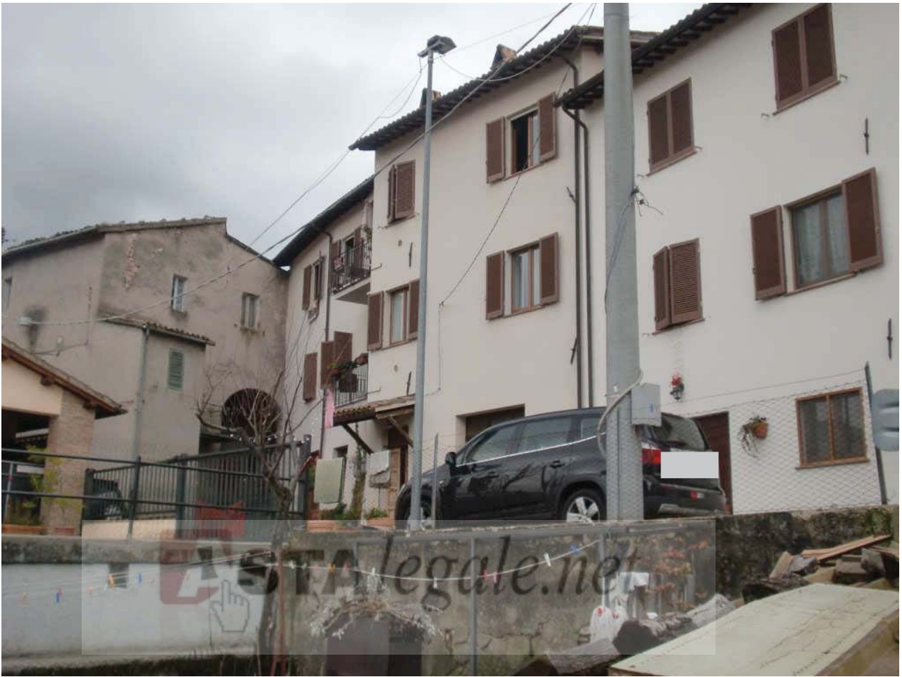
FOTO N. 1 – LATO OVEST DELL'INTERO FABBRICATO
