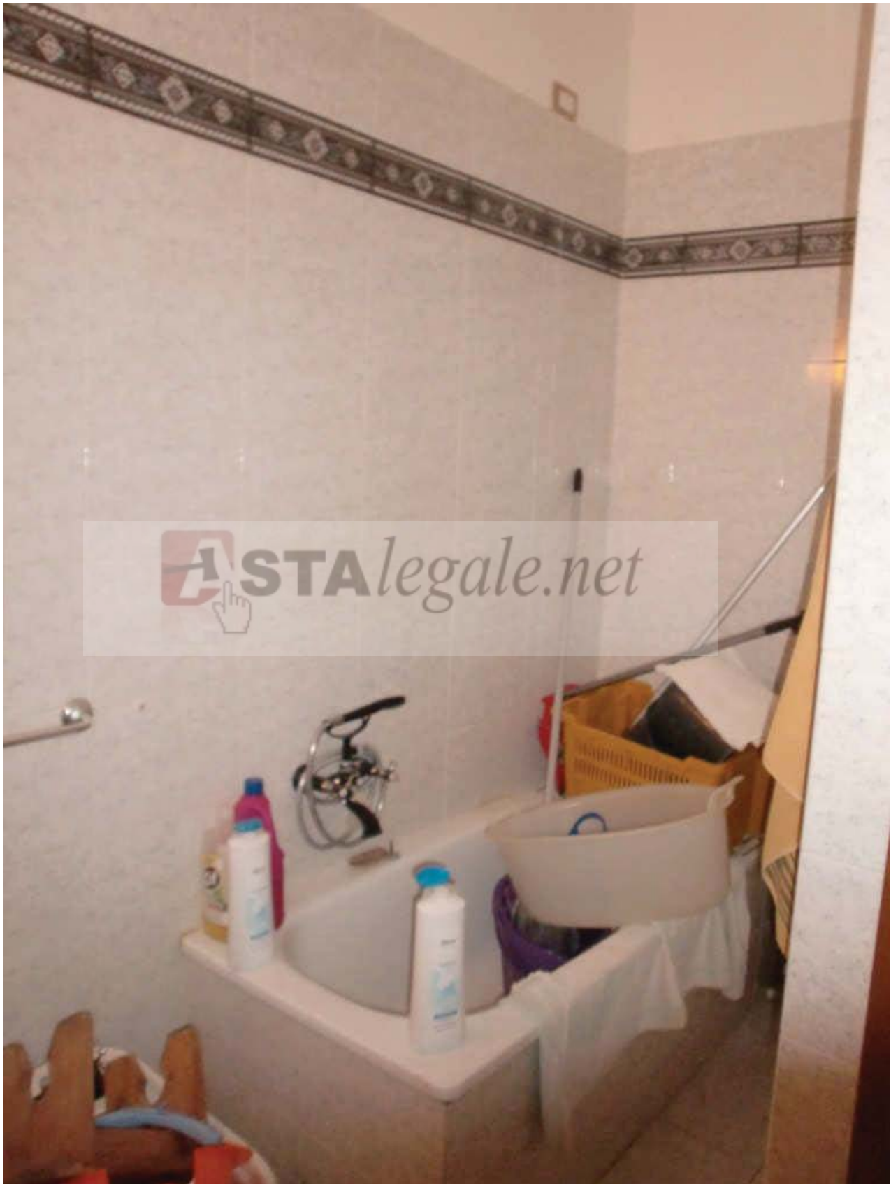
FOTO N. 11 BAGNO AL PIANO TERRA
