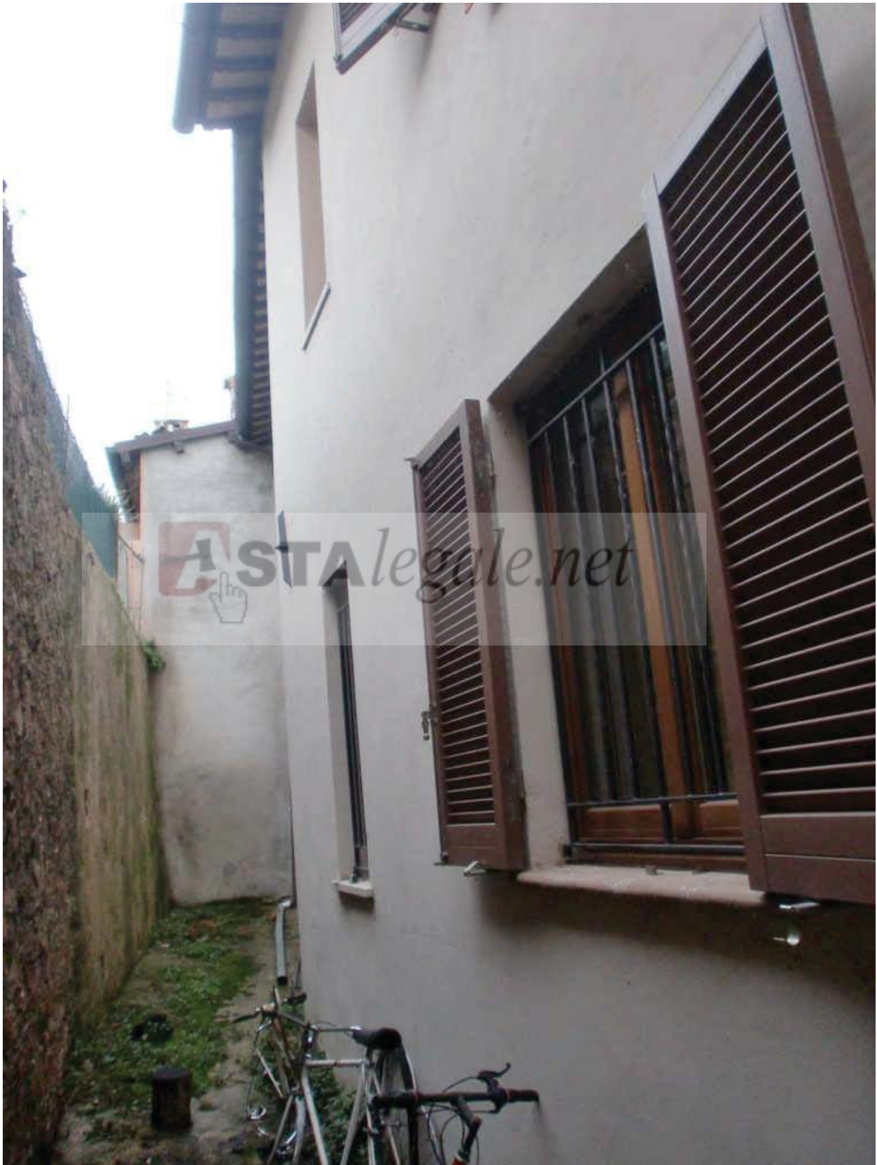
FOTO N. 6 LATO EST DELL'INTERO FABBRICATO
