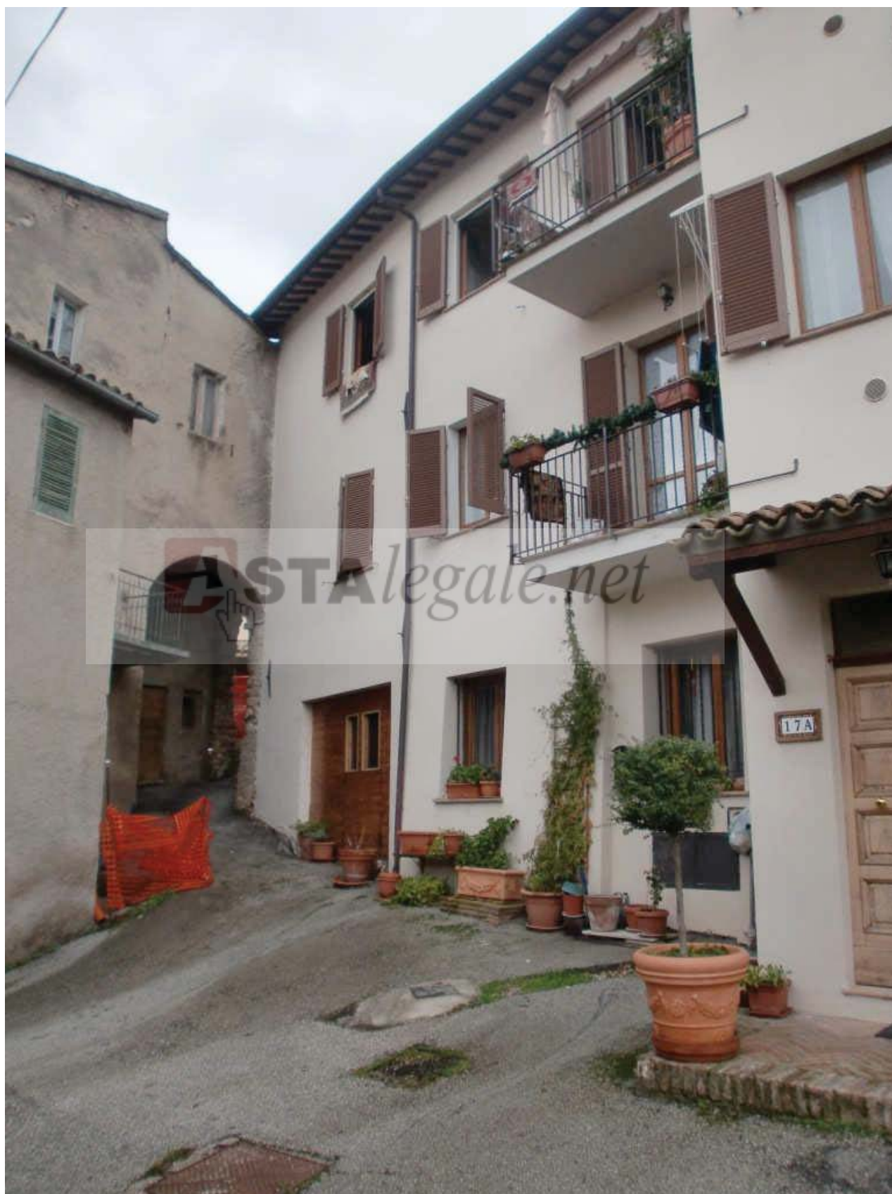
FOTO N. 3 LATO OVEST DELL'INTERO FABBRICATO
