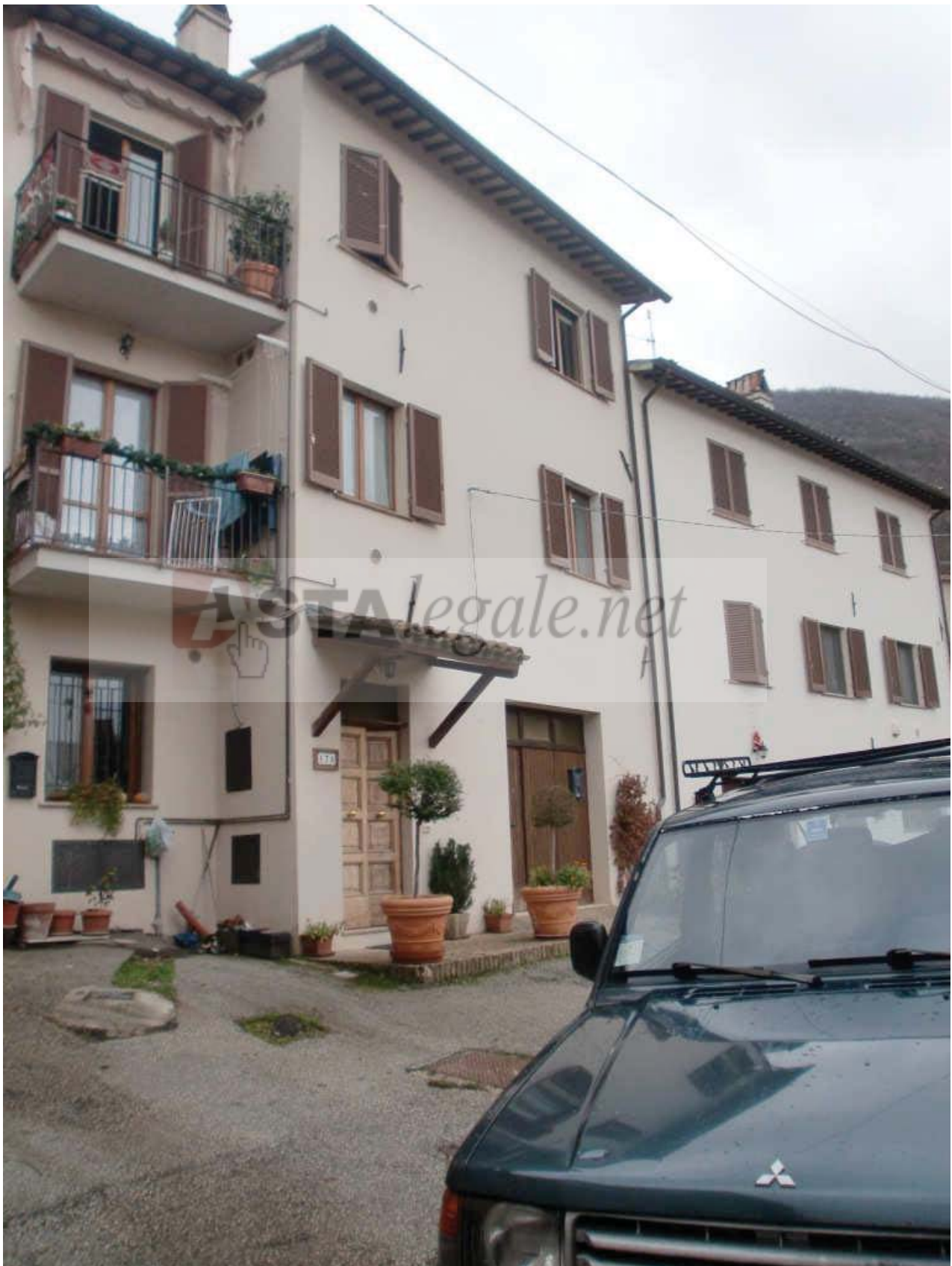
FOTO N. 2 – LATO OVEST DELL'INTERO FABBRICATO
