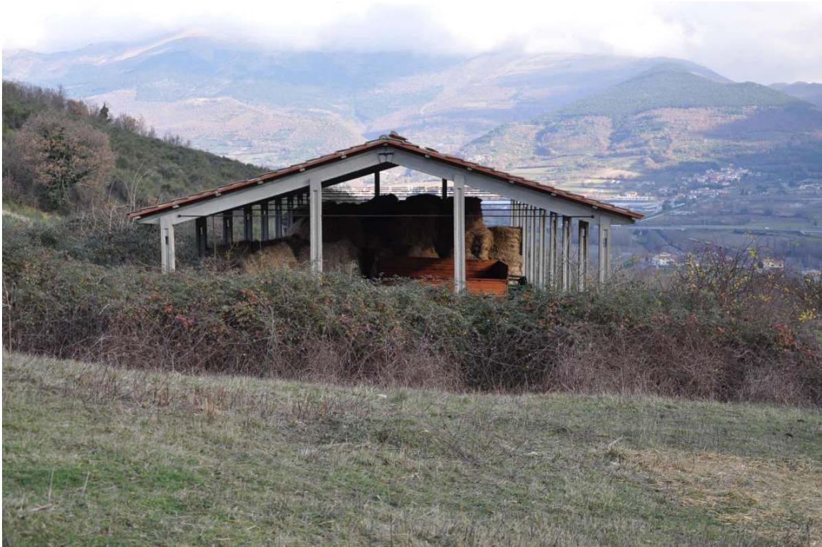
FOTO 35 FABBRICATO “FIENILE” (descritto al punto 5, situato nella zona ad alto rischio di dissesto idrogeologico)
