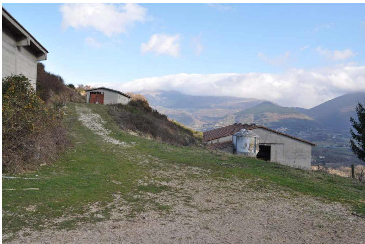
FOTO 28 VISTA D'INSIEME DEI FABBRICATI (situati nella zona ad alto rischio di dissesto idrogeologico)
