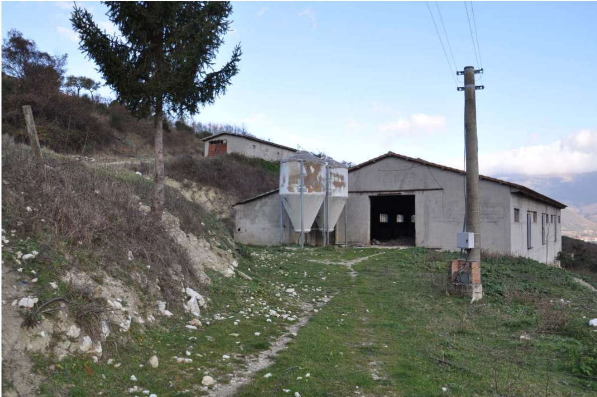
FOTO 31 FABBRICATO “STALLA” (descritto al punto 5, situato nella zona ad alto rischio di dissesto idrogeologico)
