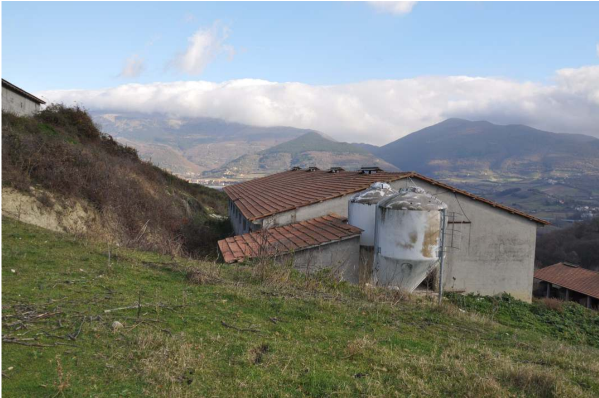
FOTO 33 FABBRICATO “STALLA” (descritto al punto 4, situato nella zona ad alto rischio di dissesto idrogeologico)
