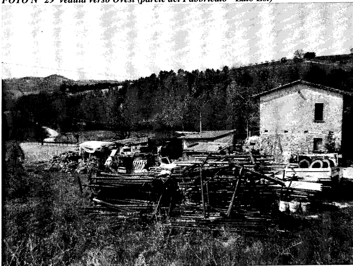
FOTO N° 29 veduta verso Ovest (parete del Fabbricato - Lato Est)
