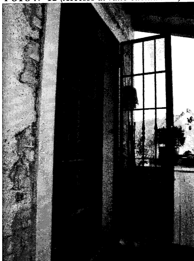
FOTO N° 12 (Accesso al vano cucina P.1°)
