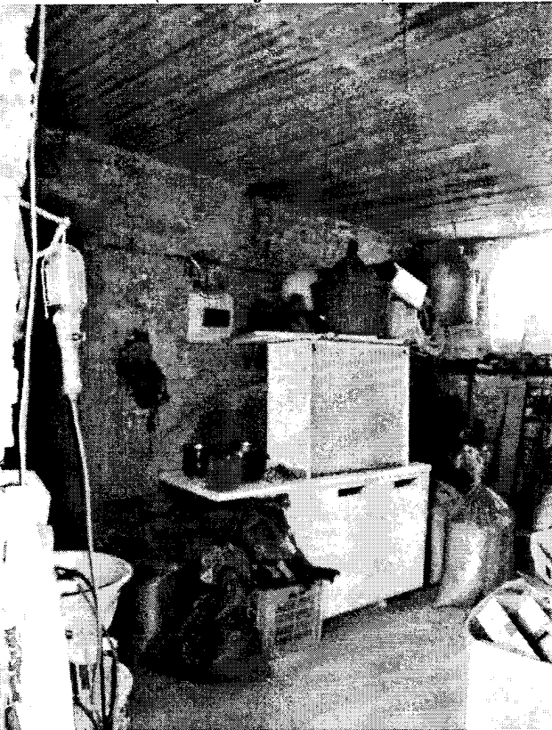
FOTO N° 6 (1° vano fondo P.T.)
