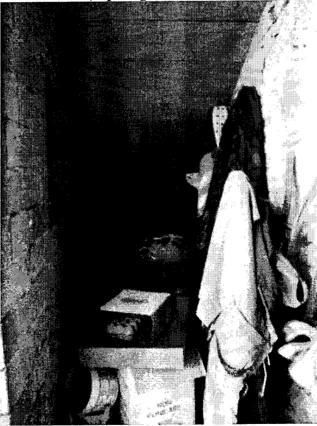
FOTO N° 5 (Ripostiglio Sottoscala – P.T.)
