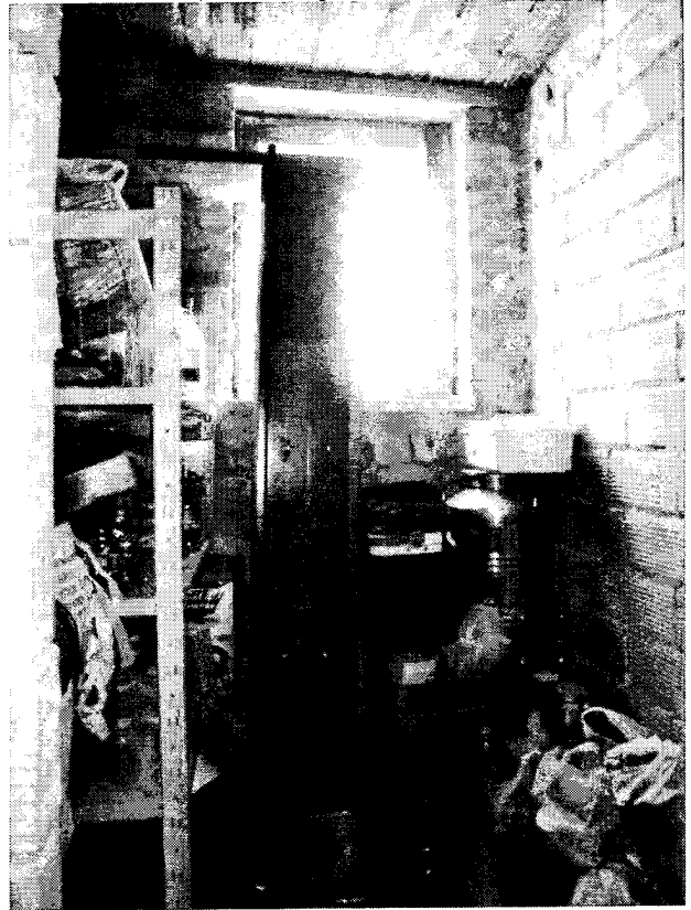
FOTO N° 9 (2° vano fondo P.T.)
