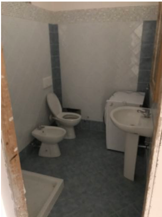
Piano Terra Immobile in corso di costruzione – Todi
