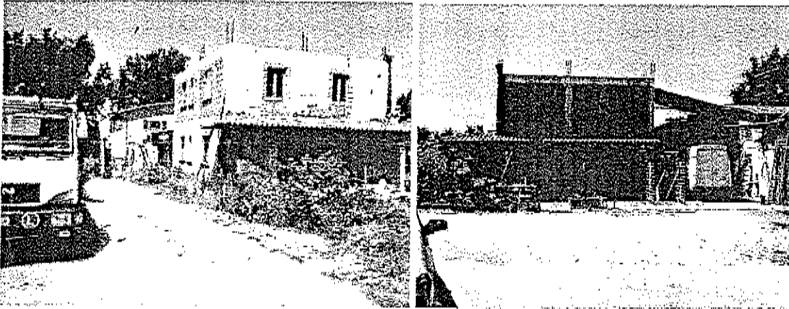
Prospetto fabbricato C-D in parte da rifinire
