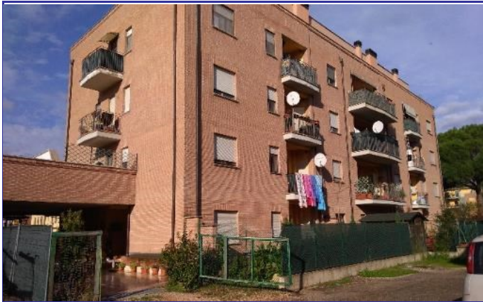
Fig. 3 - Prospetto sud-est della palazzina.
