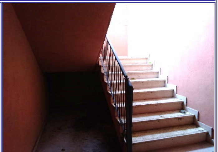
Fig. 6 - Una rampa della scala.
