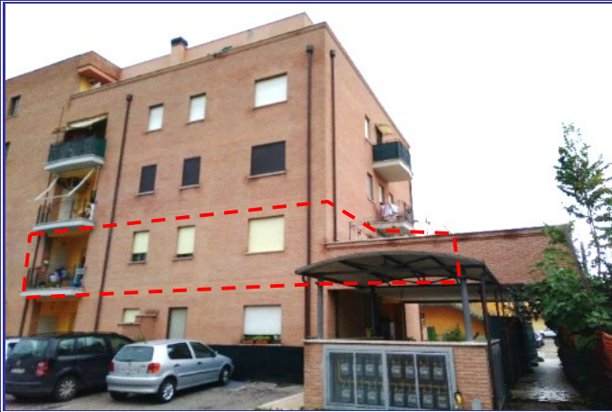
Fig. 1 – Identificazione esterna della posizione dell'appartamento nella palazzina.
