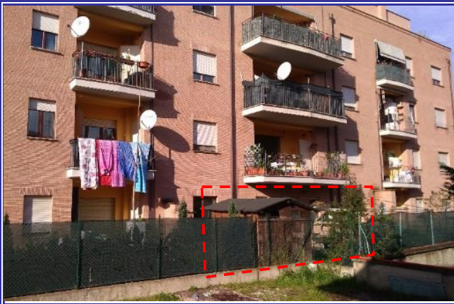
Fig. 1 – Identificazione esterna della posizione dell'appartamento nella palazzina.
