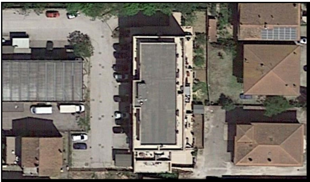
Foto aerea ravvicinata della palazzina oggetto di stima.
