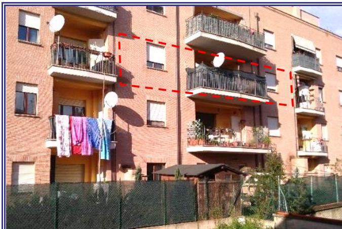
Fig. 1 – Identificazione esterna della posizione dell'appartamento nella palazzina.
