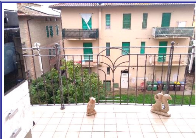
Fig. 2 – Vista dall'interno del terrazzo dell'appartamento.
