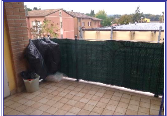
Fig. 2 – Vista dall'interno del terrazzo dell'appartamento.
