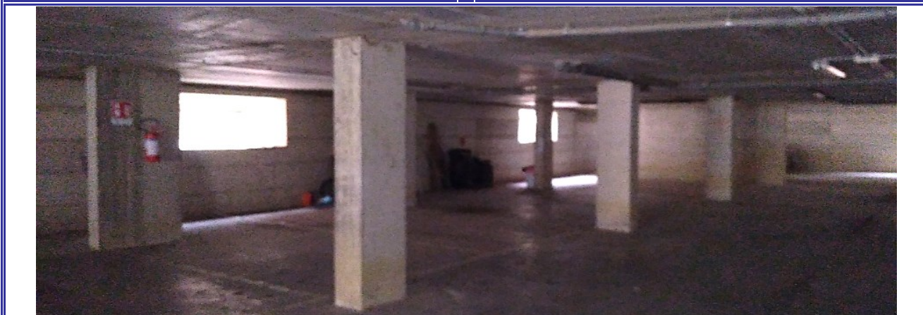
Fig. 8 – Il posto auto è solo uno spazio senza pareti al piano sottostrada.
