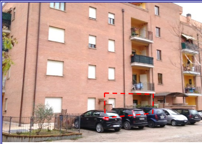
Fig. 1 – Identificazione esterna della posizione dell'appartamento costituente il lotto 1 nella palazzina.
