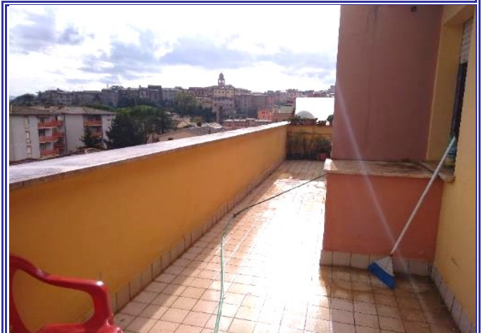
Fig. 3 - Vista dall'interno del terrazzo dell'appartamento.
