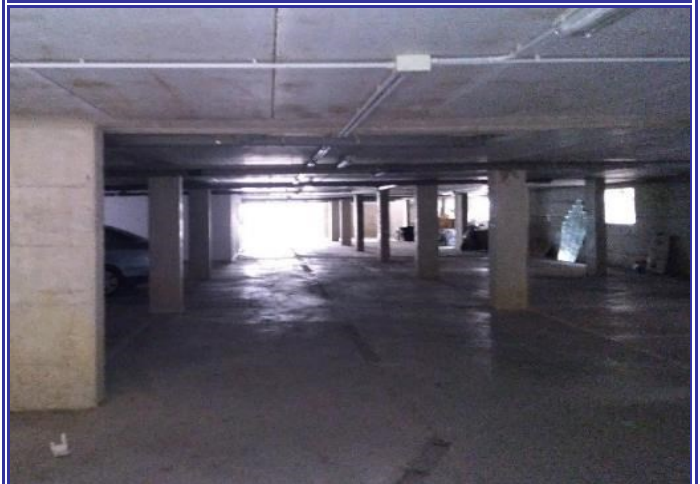
Fig. 8 - Vista da sud del piano interrato ad uso garage.
