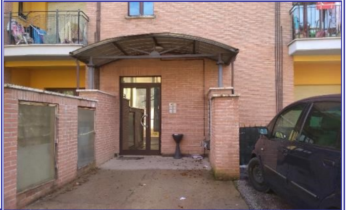
Fig. 4 - L'ingresso condominiale è unico.
