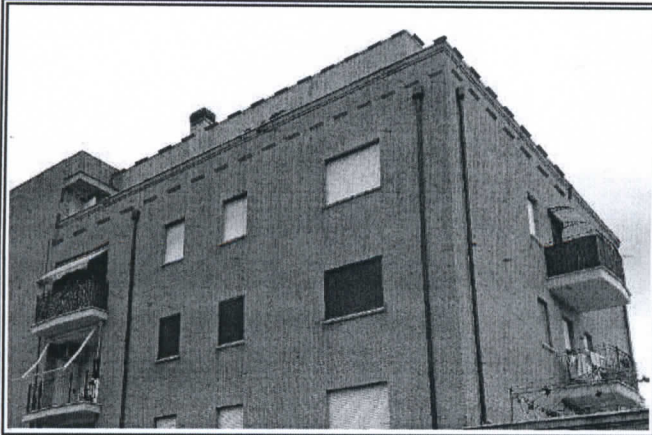
Fig. 1 – Identificazione esterna della posizione dell'appartamento nella palazzina.
