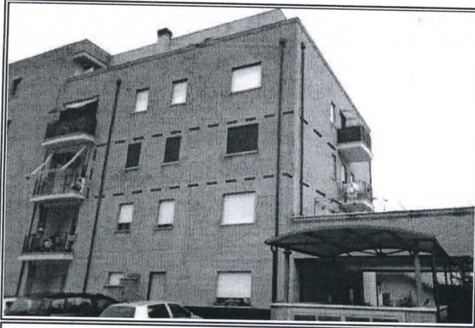
Fig. 1 – Identificazione esterna della posizione dell'appartamento nella palazzina.
