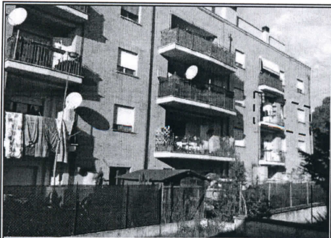
Fig. 1 – Identificazione esterna della posizione dell'appartamento nella palazzina.
