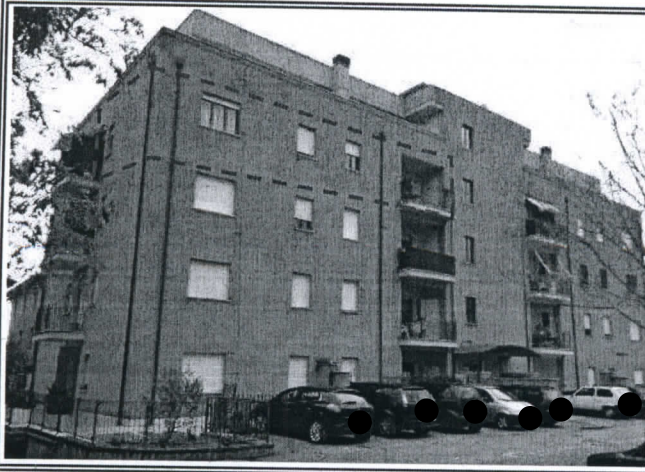
Fig. 1 – Identificazione esterna della posizione dell'appartamento nella palazzina.
