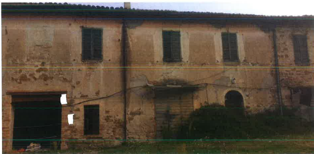
Foto n° 18: prospetto sud dell'immobile oggetto di stima
