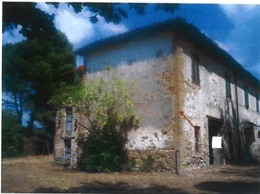
Foto n° 4: lato ovest dell'immobile oggetto di stima ( si evidenziano gli angoli del fabbricato realizzati con pietra squadrata )
