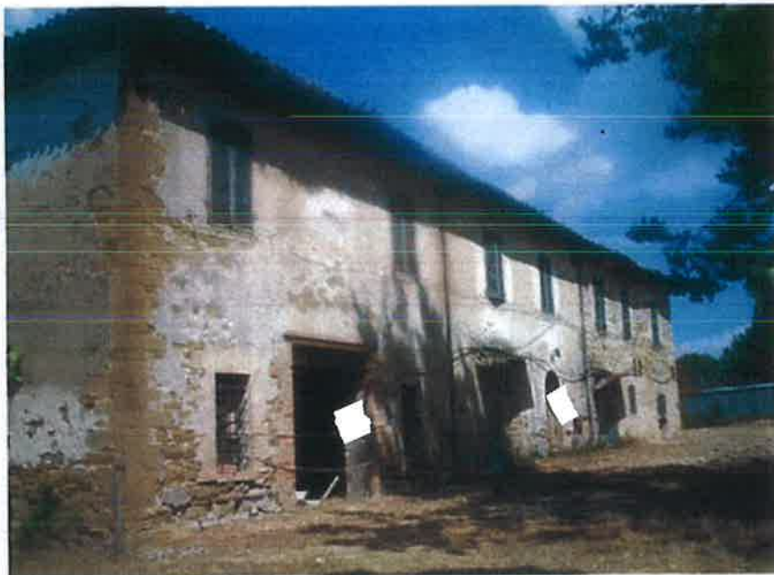
Foto n° 3: prospetto sud dell'immobile oggetto di stima
