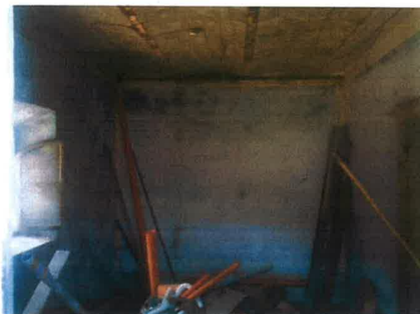
Foto n° 13: interno del locale magazzino al piano Terra
