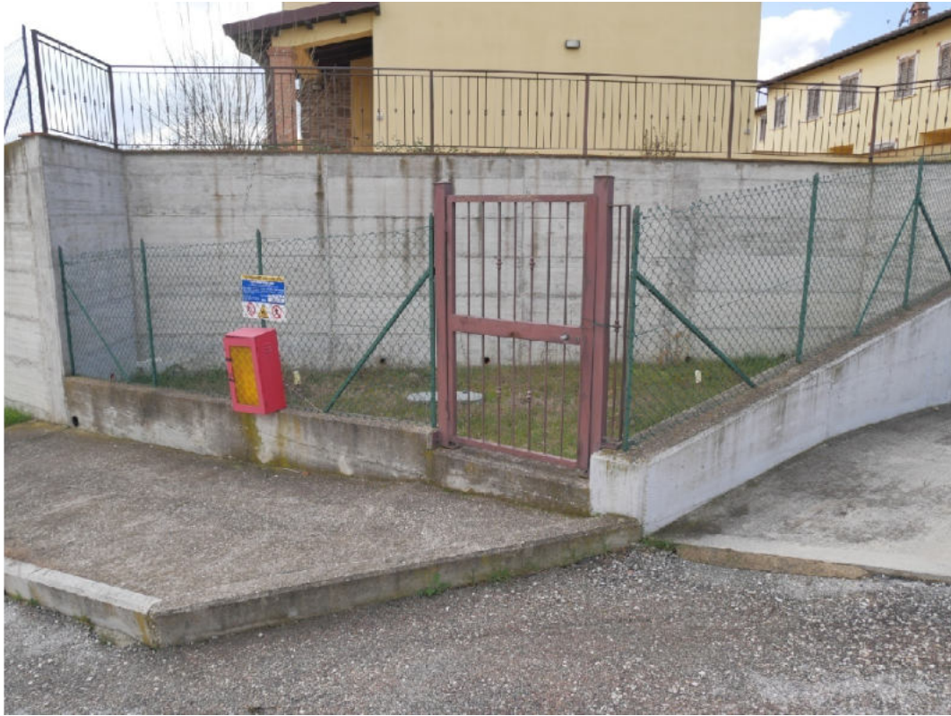
Foto n.5 – Area serbatoio Gpl interrato comune
