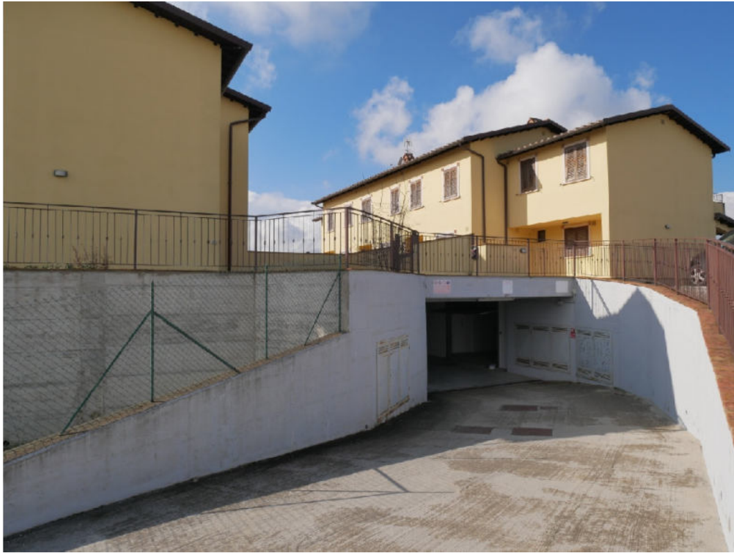
Foto n.3 – Rampa di accesso garage
