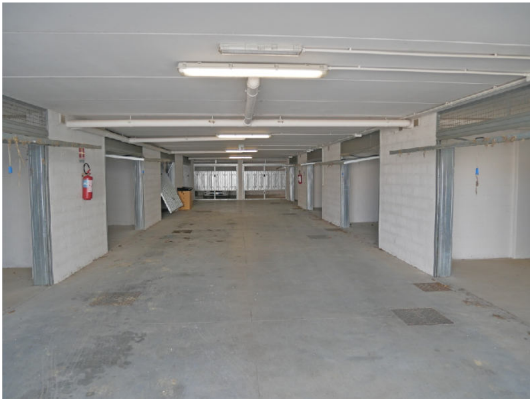
Foto n.4 – Corsia di manovra garage
