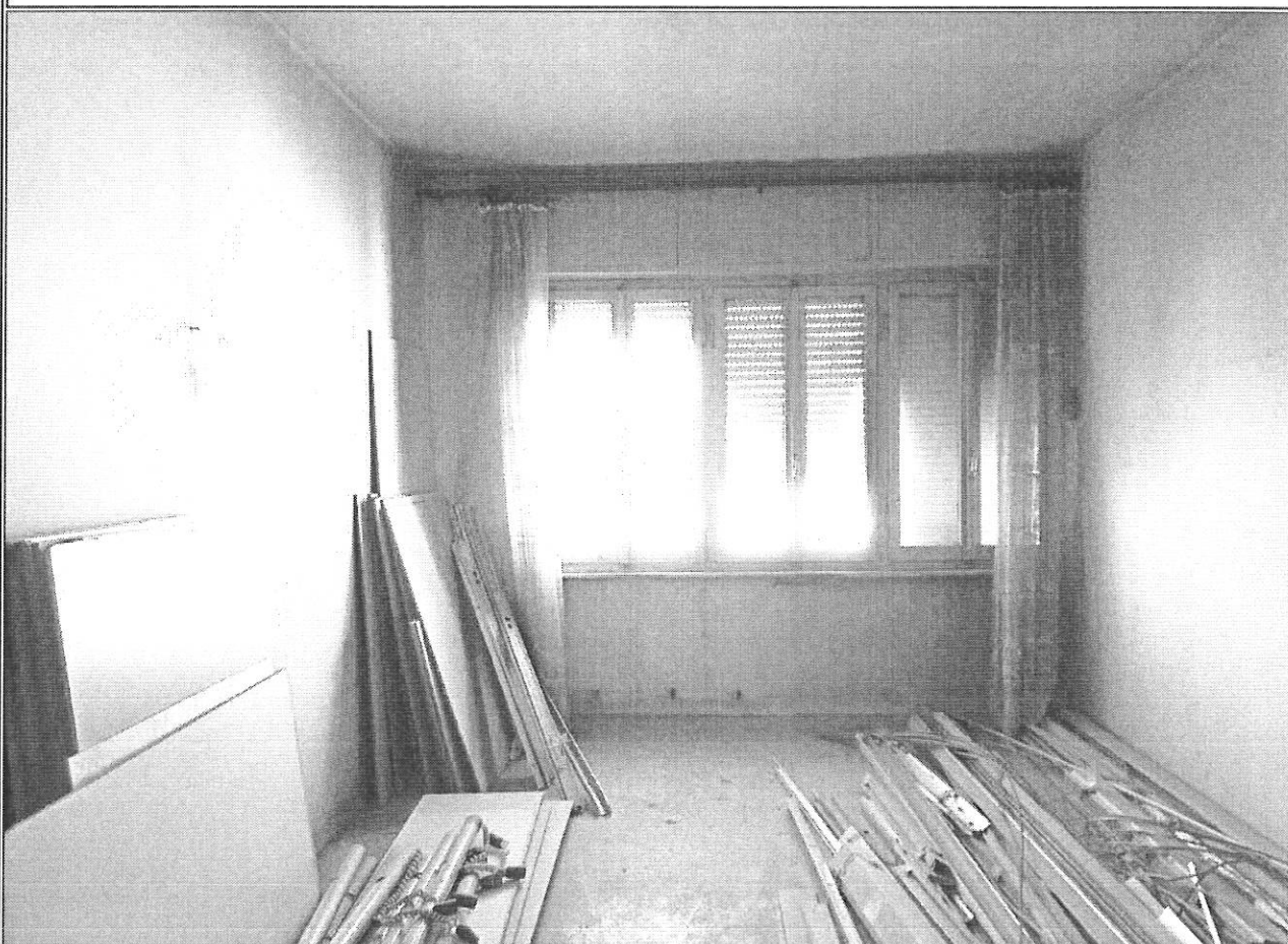
Fig. 22 – Un ufficio del piano 4°. Tale livello era stato interessato da dei lavori di ristrutturazione interna.
