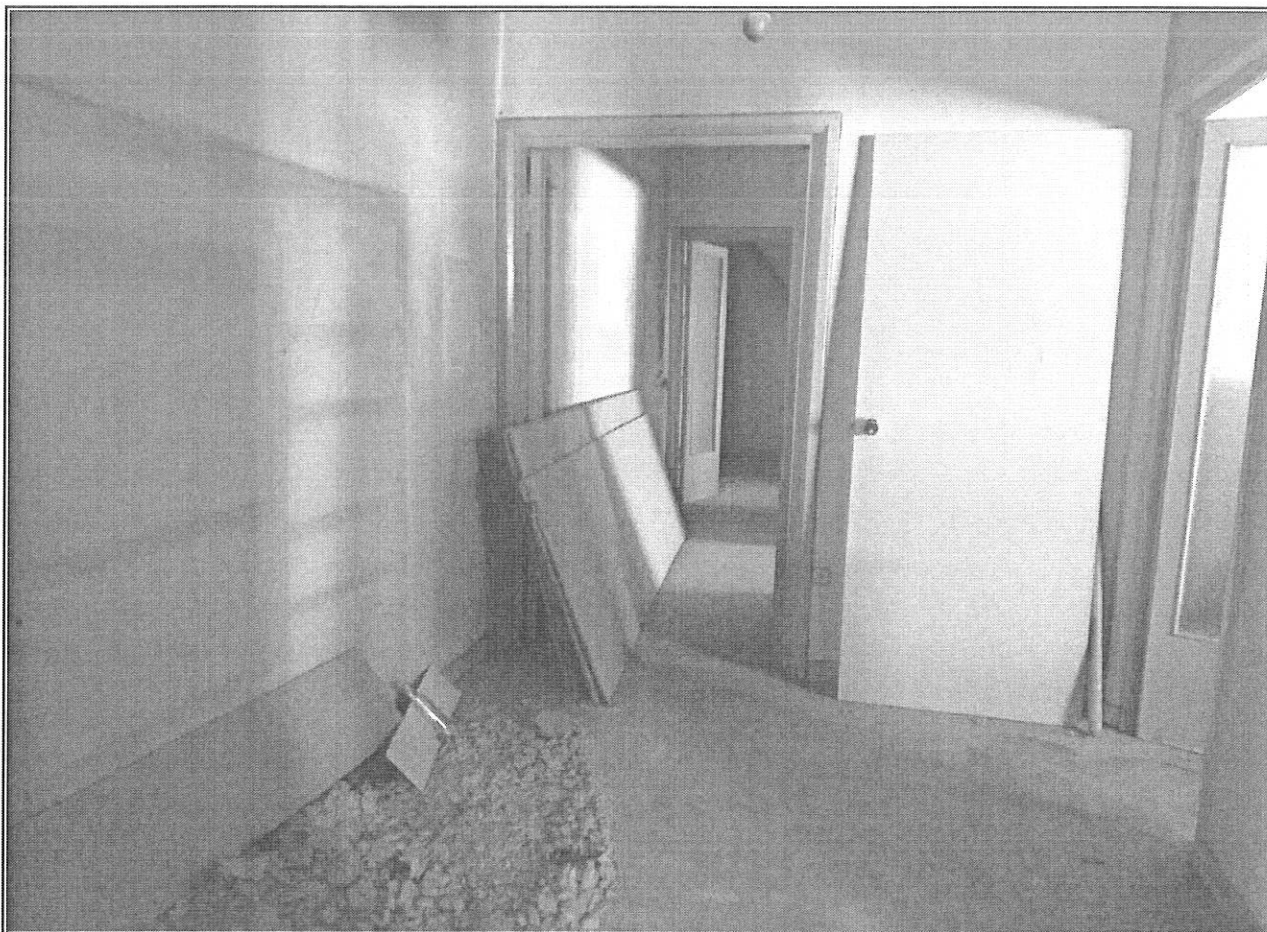
Fig. 21 – La sala di attesa al piano 4°.
