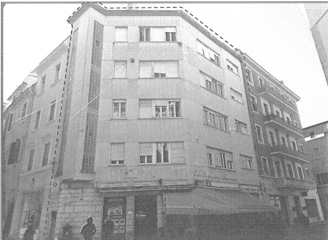
Fig. 1 – Gli immobili sono costituiti da locali ufficio e altre tipologie ricavati in una intera palazzina inserita nel continuum architettonico nel centro storico di Foligno.
