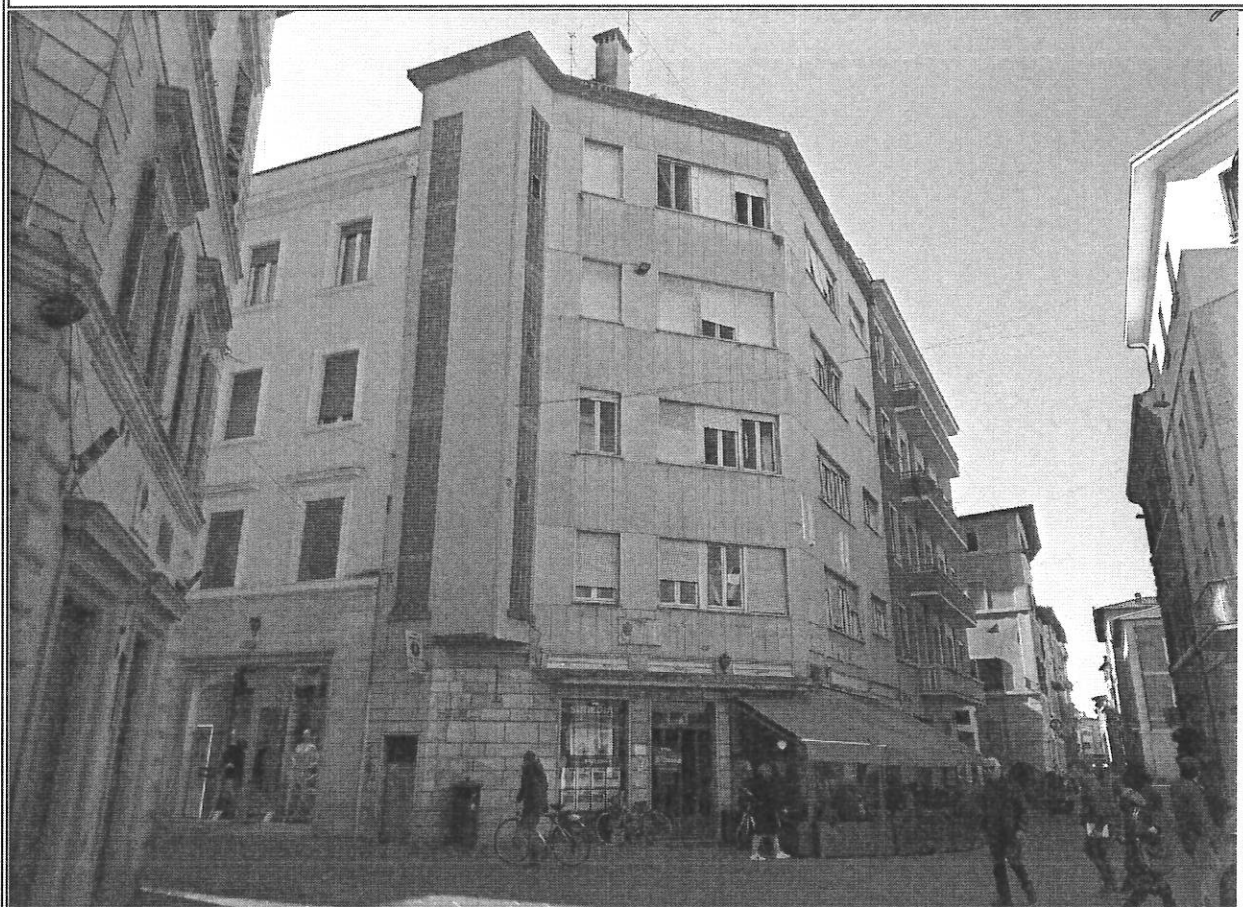
Fig. 2 – La palazzina si sviluppa su 7 livelli di cui 6 fuori terra, compreso un lastrico solare, ed un livello interrato in passato adibito a centrale termica.
