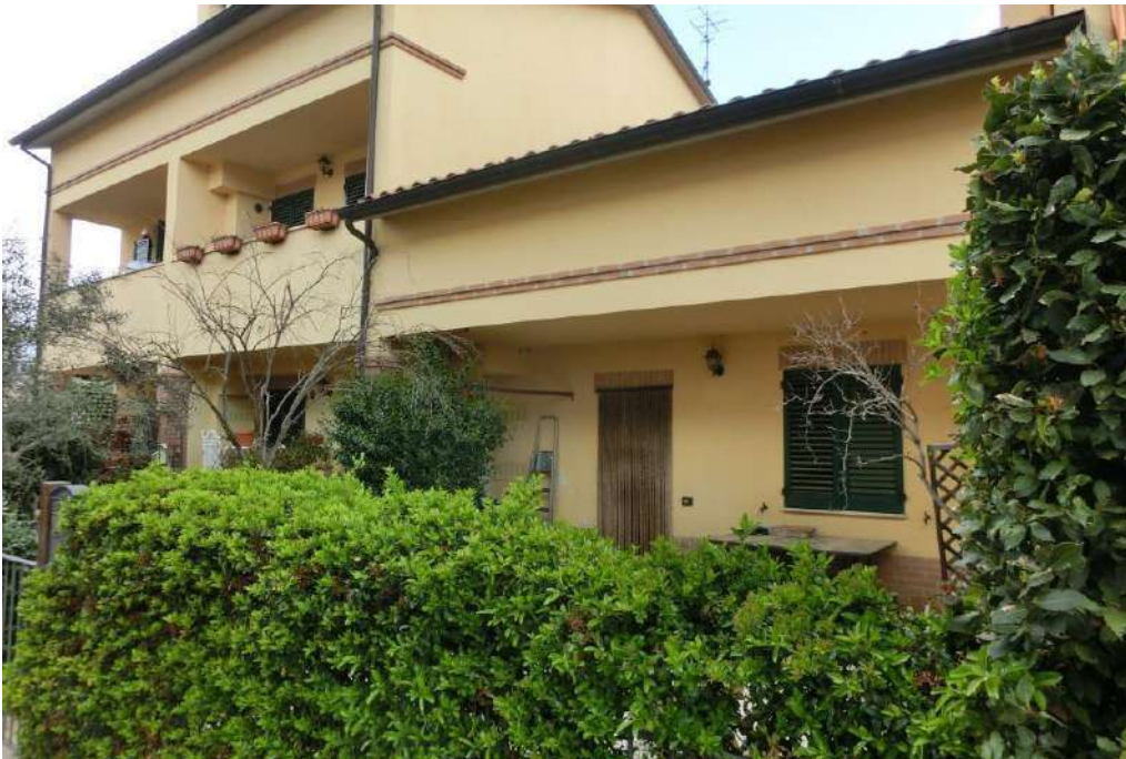
FOTO N° 5 – Prospetto e Portico (veduta Sud-Est)
