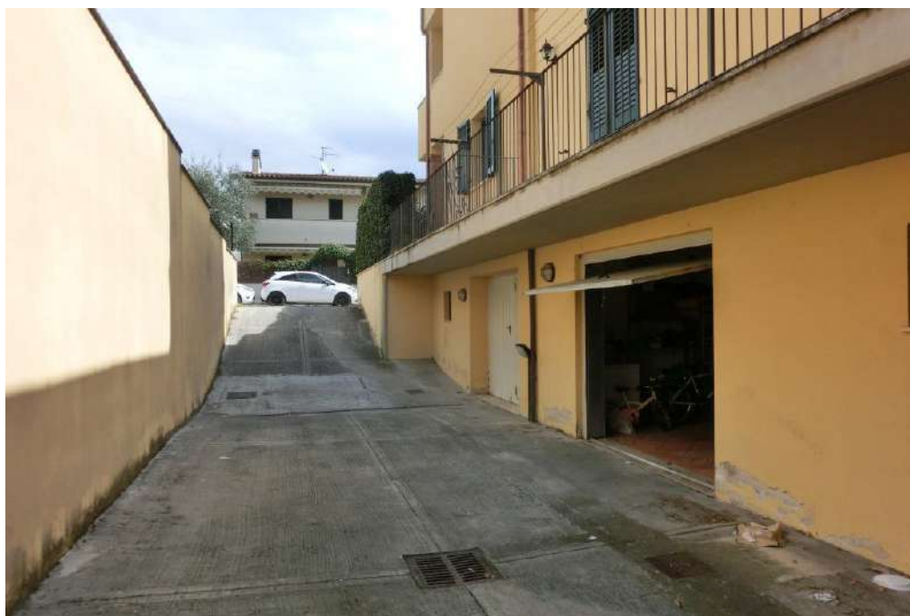
FOTO N° 13 – Rampa/discenderia di accesso al P. 1° Sott.da (veduta da Ovest verso Est)
