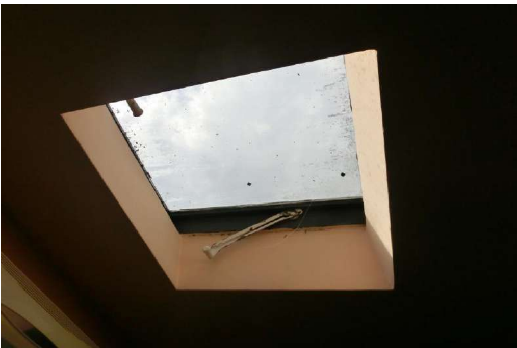
FOTO N° 31 – Piano Primo (Lucernaio Letto)
