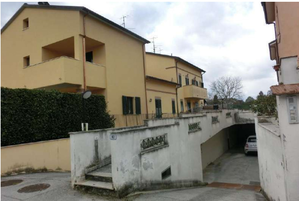
FOTO N° 10 – Prospetto (veduta Nord-Est)
