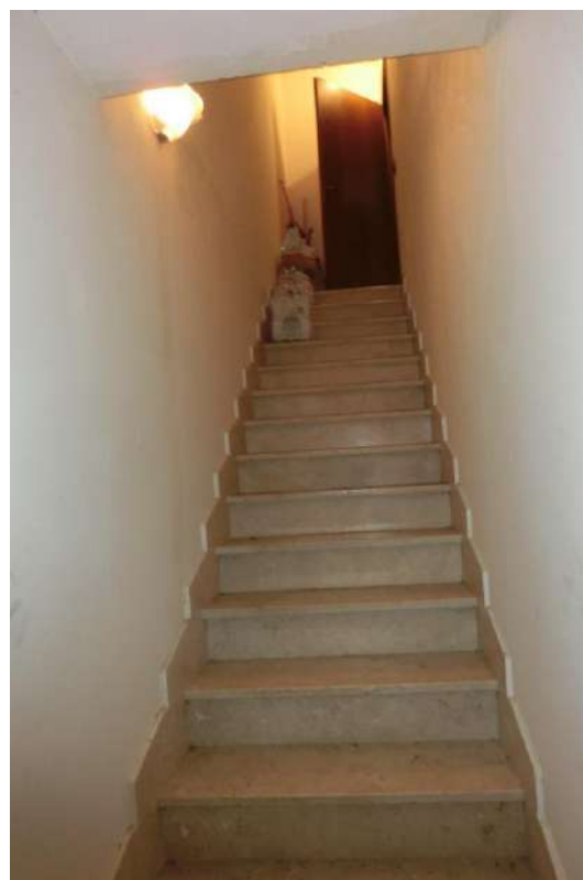
FOTO N° 39 - Scala di accesso al P. T. dal P.1°S.
