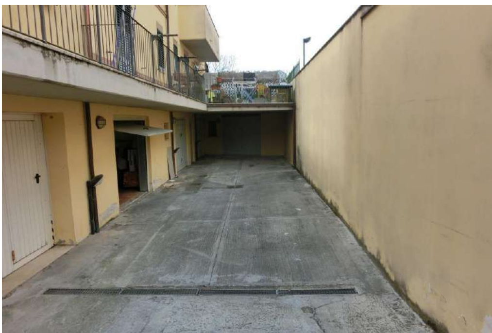
FOTO N° 12 – Rampa/discenderia di accesso al P. 1° Sott.da (veduta da Est verso Ovest)
