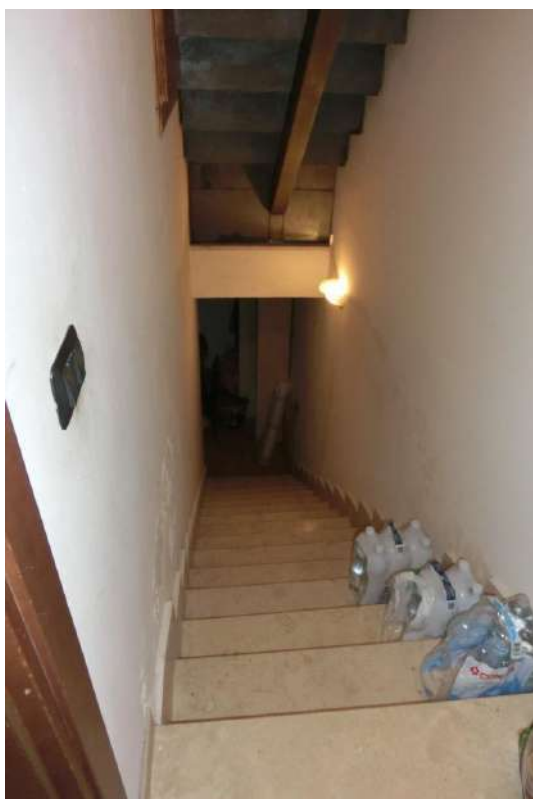
FOTO N° 38 – Scala di accesso al P. 1°S. dal P.T.
