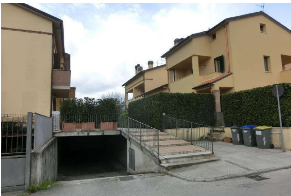
FOTO N° 2 – via Santo Spes di Spoleto nc. 86 (veduta da Est verso Ovest)
