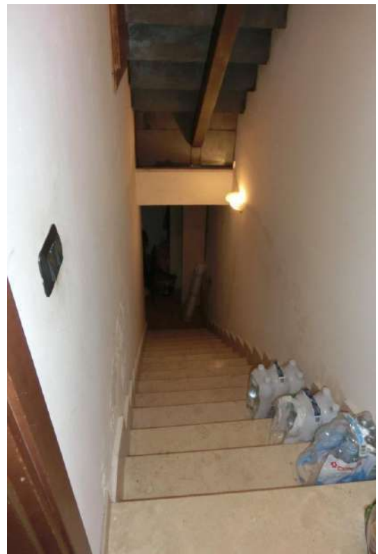
FOTO N° 8 – Scala di Accesso al piano 1°Sott.da
