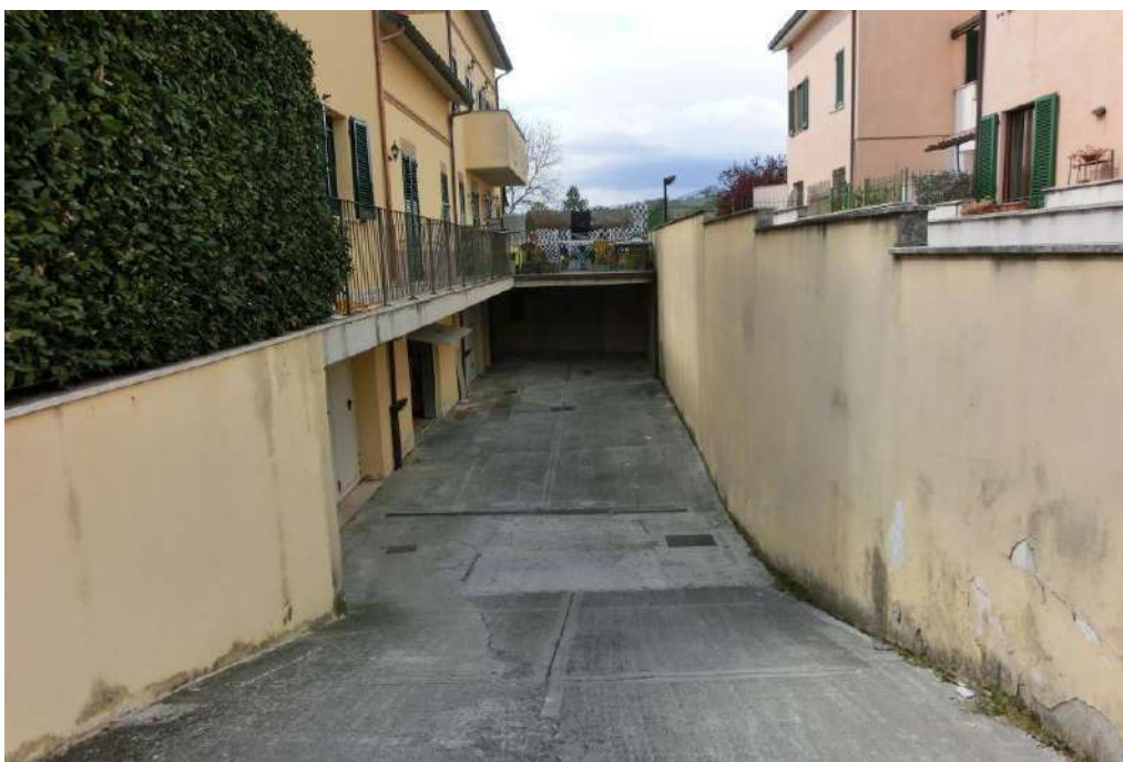
FOTO N° 11 – Rampa/discenderia di accesso al P. 1° Sott.da (veduta da Est verso Ovest)
