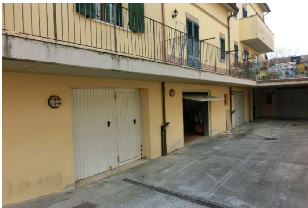
FOTO N° 14 – Rampa/discenderia di accesso al P. 1° Sott.da (veduta Nord-Est)
