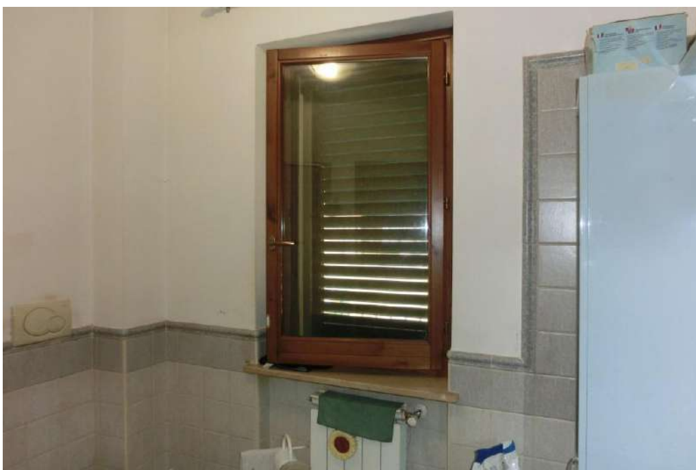
FOTO N° 14 – Piano Terra (Bagno)
