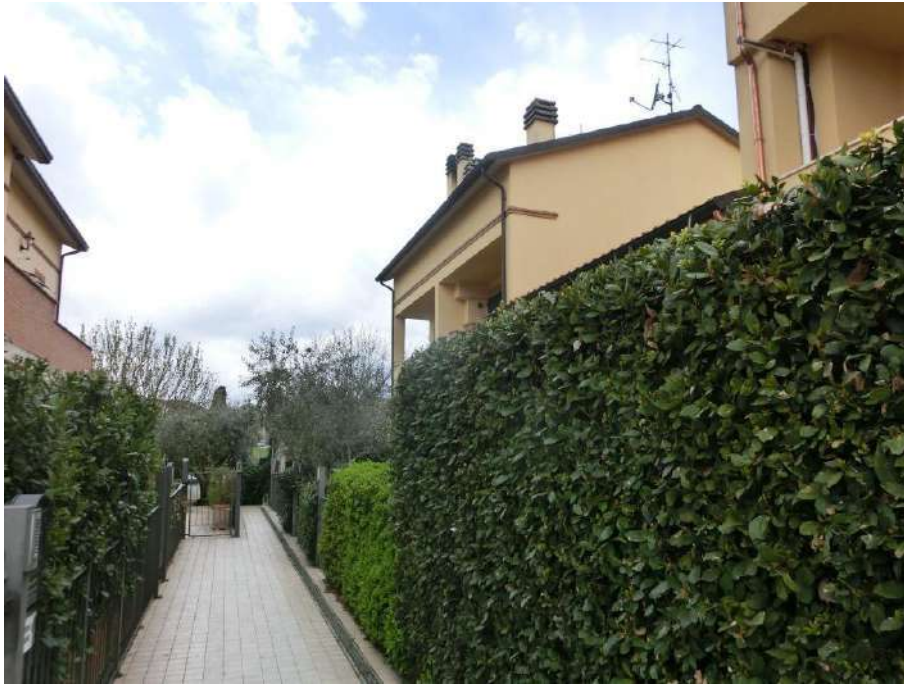
FOTO N° 3 – vialetto condominiale di accesso alle varie U.I. (veduta Sud-Est)
