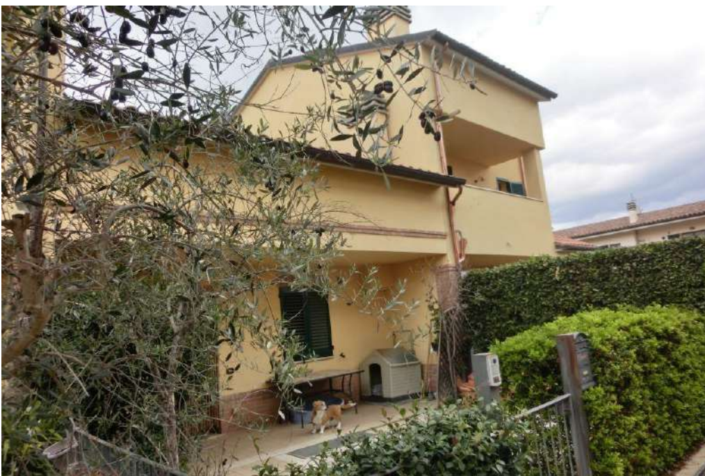
FOTO N° 6 – Prospetto e Portico (veduta Sud-Ovest)
