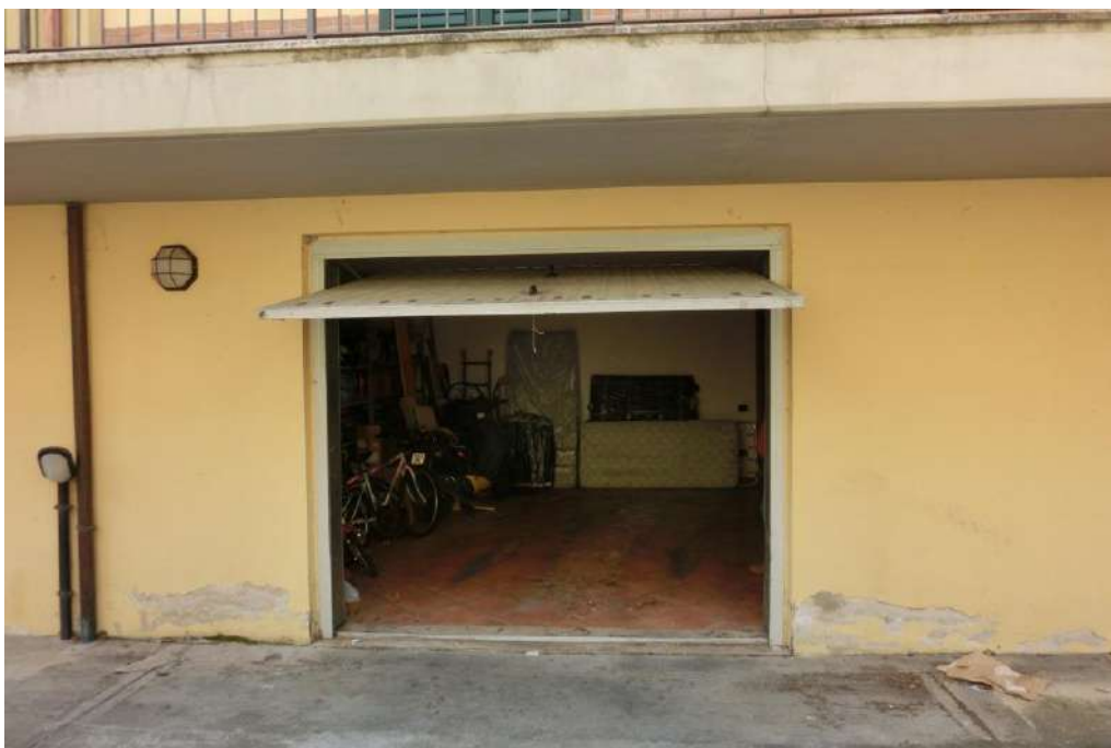
FOTO N° 16 – Porta di Accesso al Locale Garage (veduta Nord)
