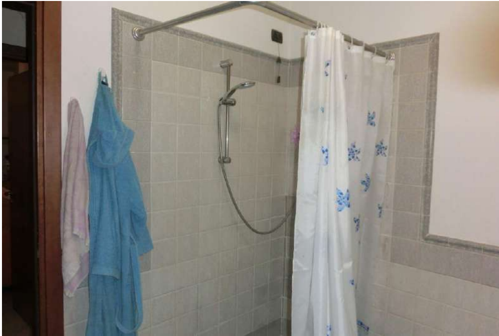
FOTO N° 11 – Piano Terra (Bagno)
