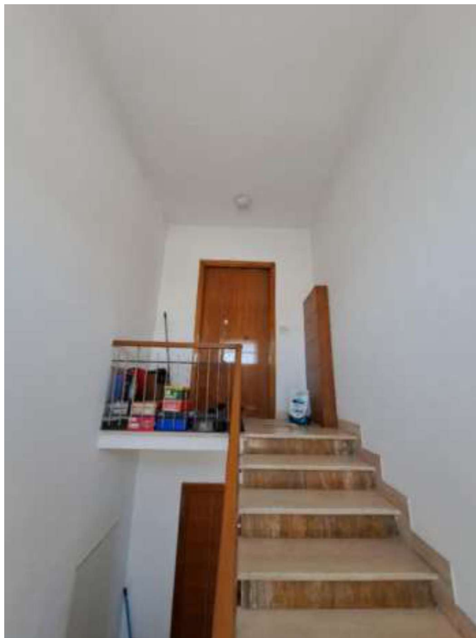
Rampa Scala Condominiale
