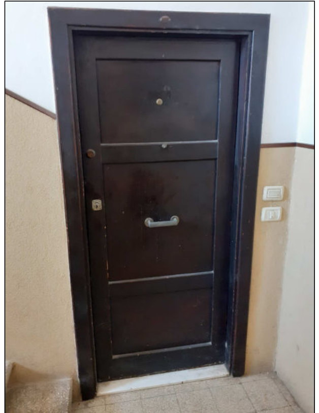
Porta immobile eseguito
