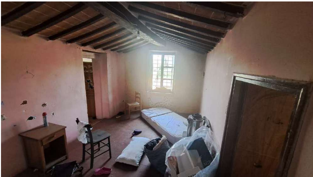
Foto 11 - Piano primo, Letto (subb. 5-5-5) e accesso all'unità immobiliare adiacente -lato opposto (subb. 6-5-6)
