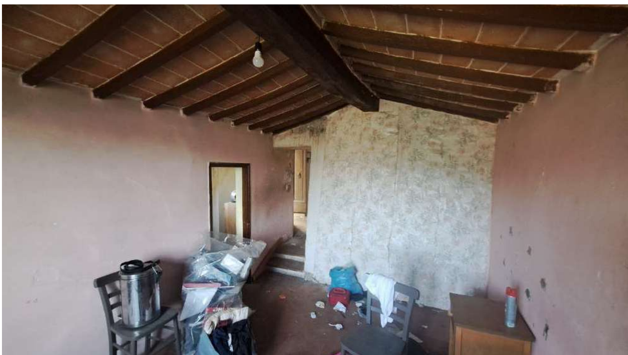
Foto 12 - Piano primo, Letto - WC (subb. 5-5-5)
