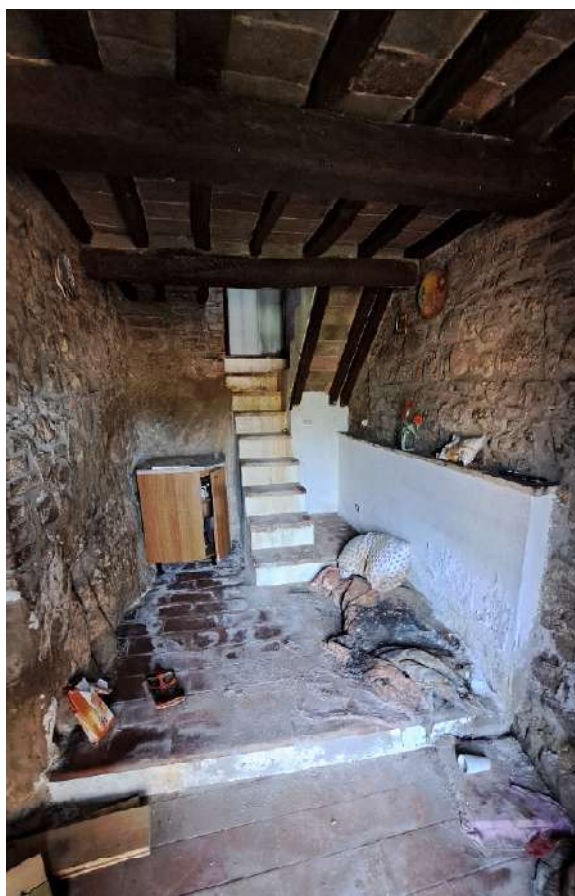
Foto 4 - Piano terra, Ingresso (subb. 6-5-6)
