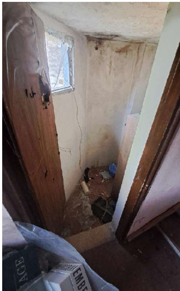
Foto 13 - Piano primo, WC (subb. 5-5-5)
