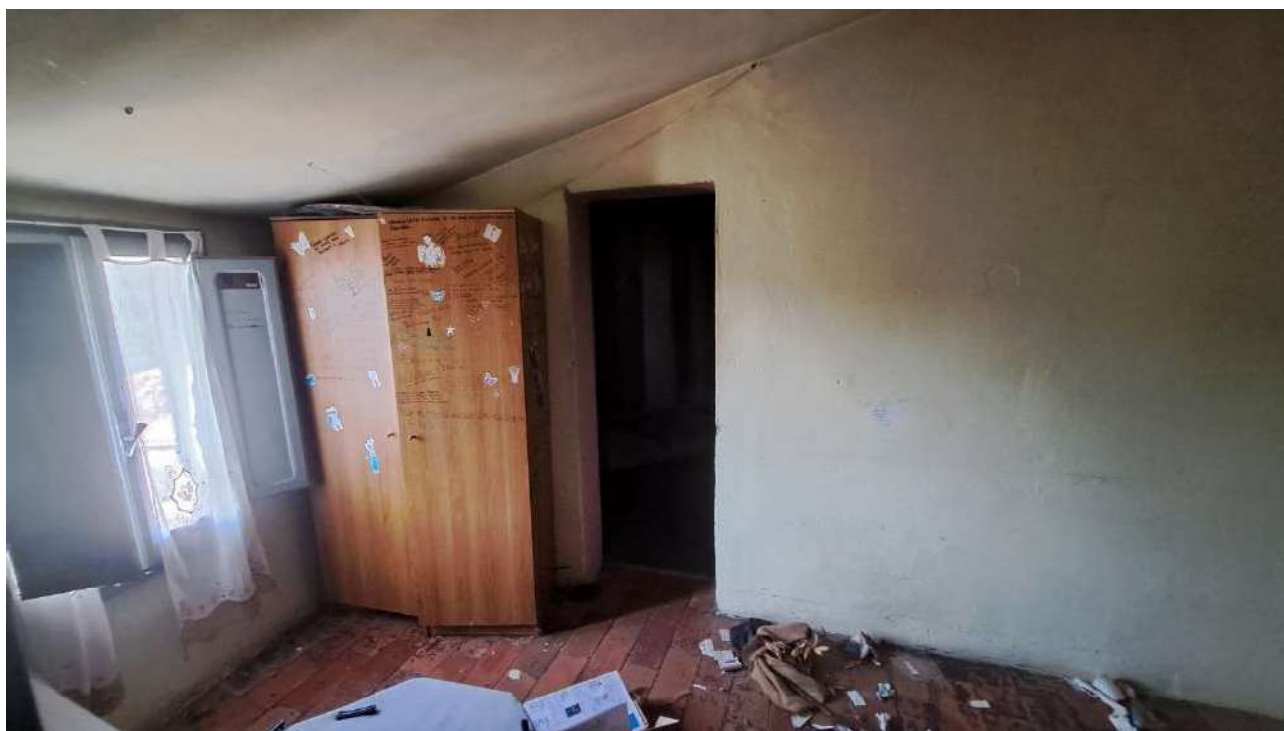
Foto 10 - Piano primo, Letto (subb. 6-5-6) e accesso all'unità immobiliare adiacente (subb. 5-5-5)
