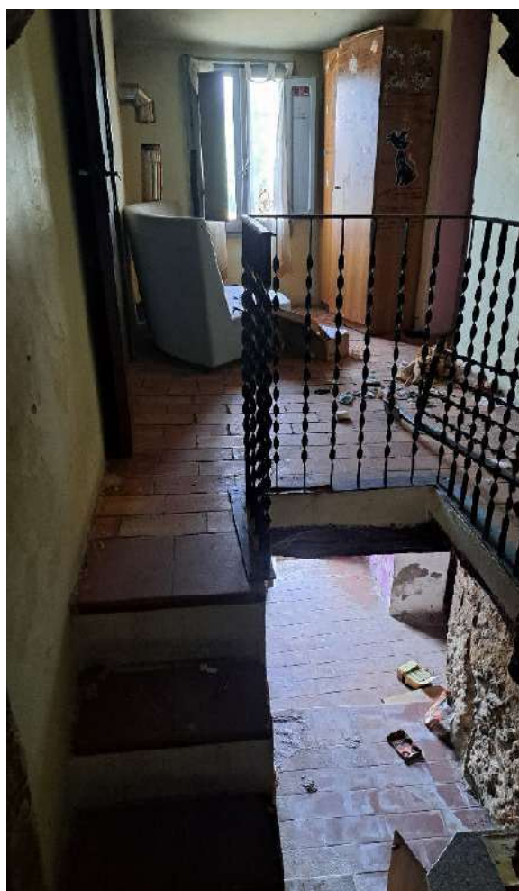
Foto 8 - Piano primo, Scala interna - Letto (subb. 6-5-6)
