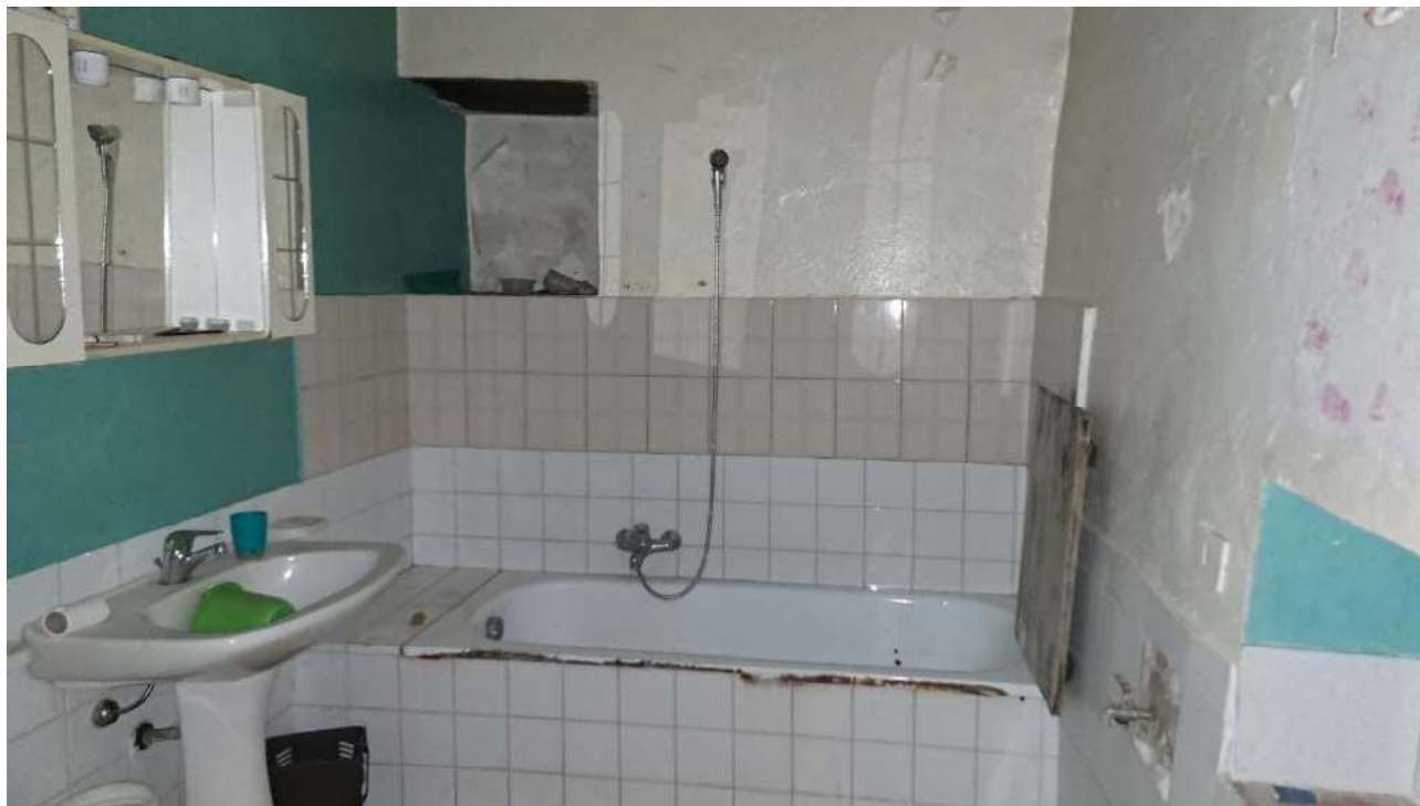
Foto 7 - Piano primo, Bagno (subb. 6-5-6)
