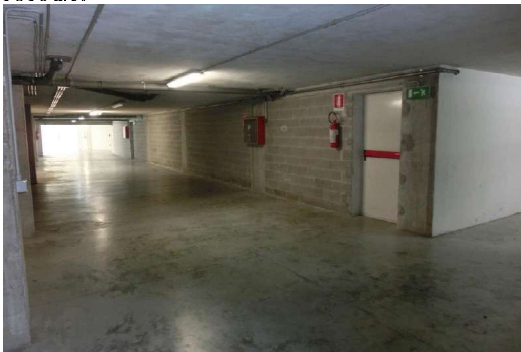
Accesso dalla rampa: interno spazio di manovra condominiale
