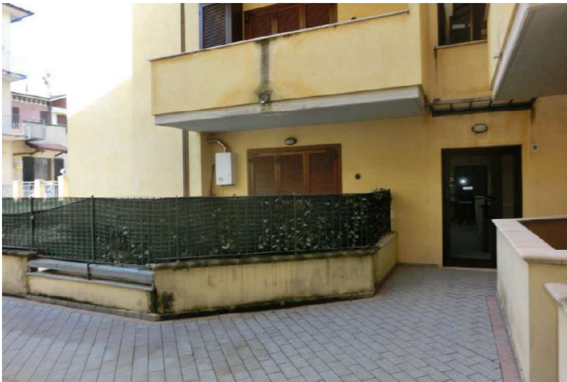
Lato Sud/Est: particolare accesso all'ingresso condominiale e alla apertura della porta-finestra del vano ingr./cucina/soggiorno con evidenziata la caldaia murale gas
