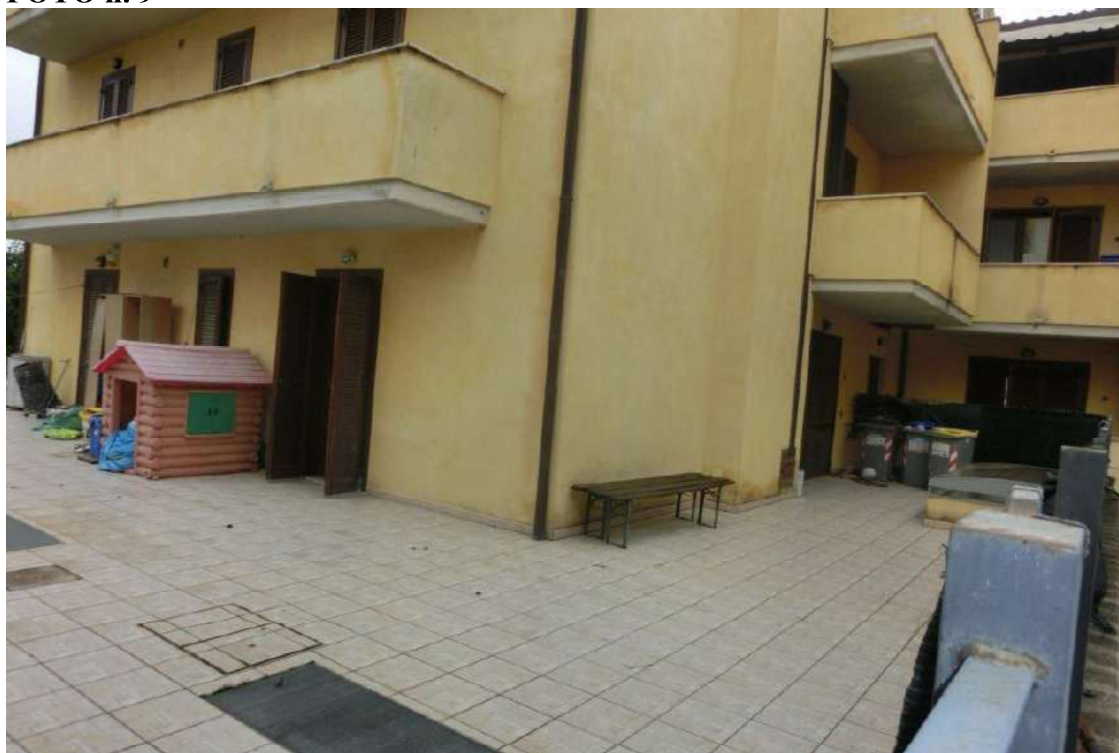
Veduta Sud-Ovest dello spazio esclusivo dell'abitazione oggetto di accertamento
