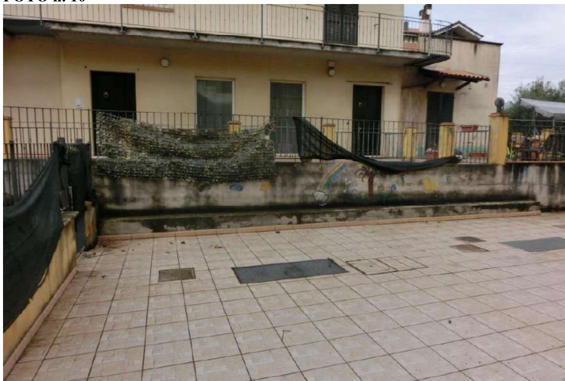
Veduta Ovest dello spazio esclusivo dell'abitazione oggetto di accertamento
