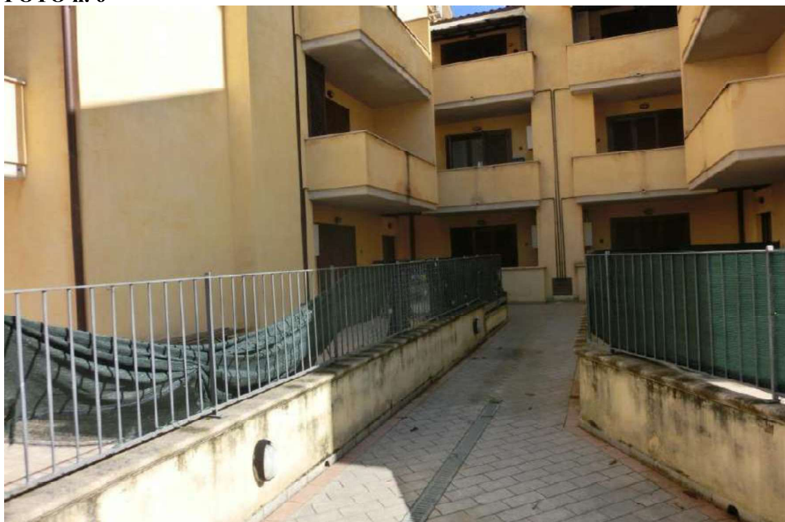
Lato Ovest: particolare accesso all'ingresso condominiale
