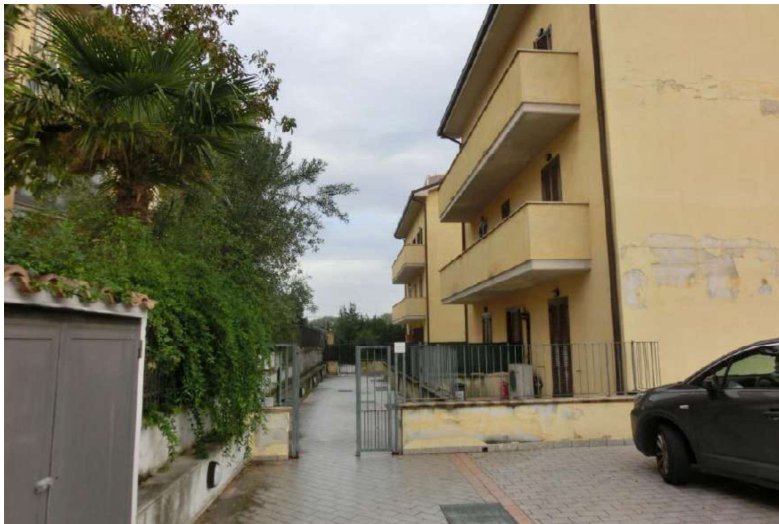
Lato Sud: particolare accesso condominiale nc. 120
