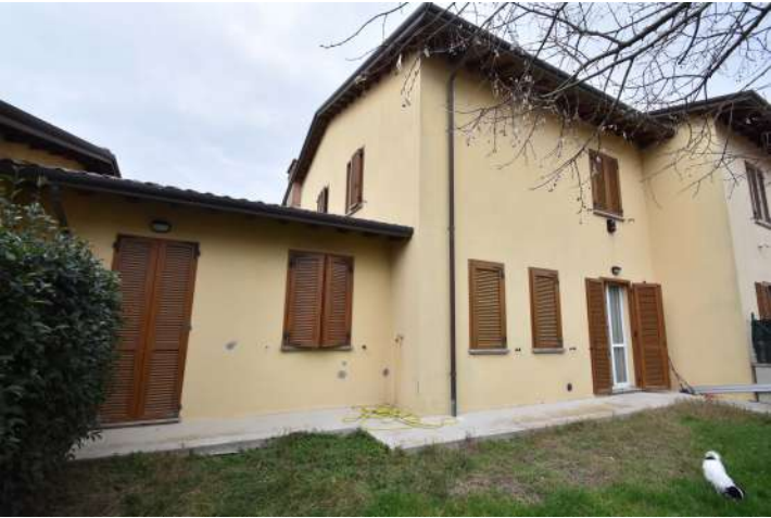
Retroprospetto su corte esclusiva
