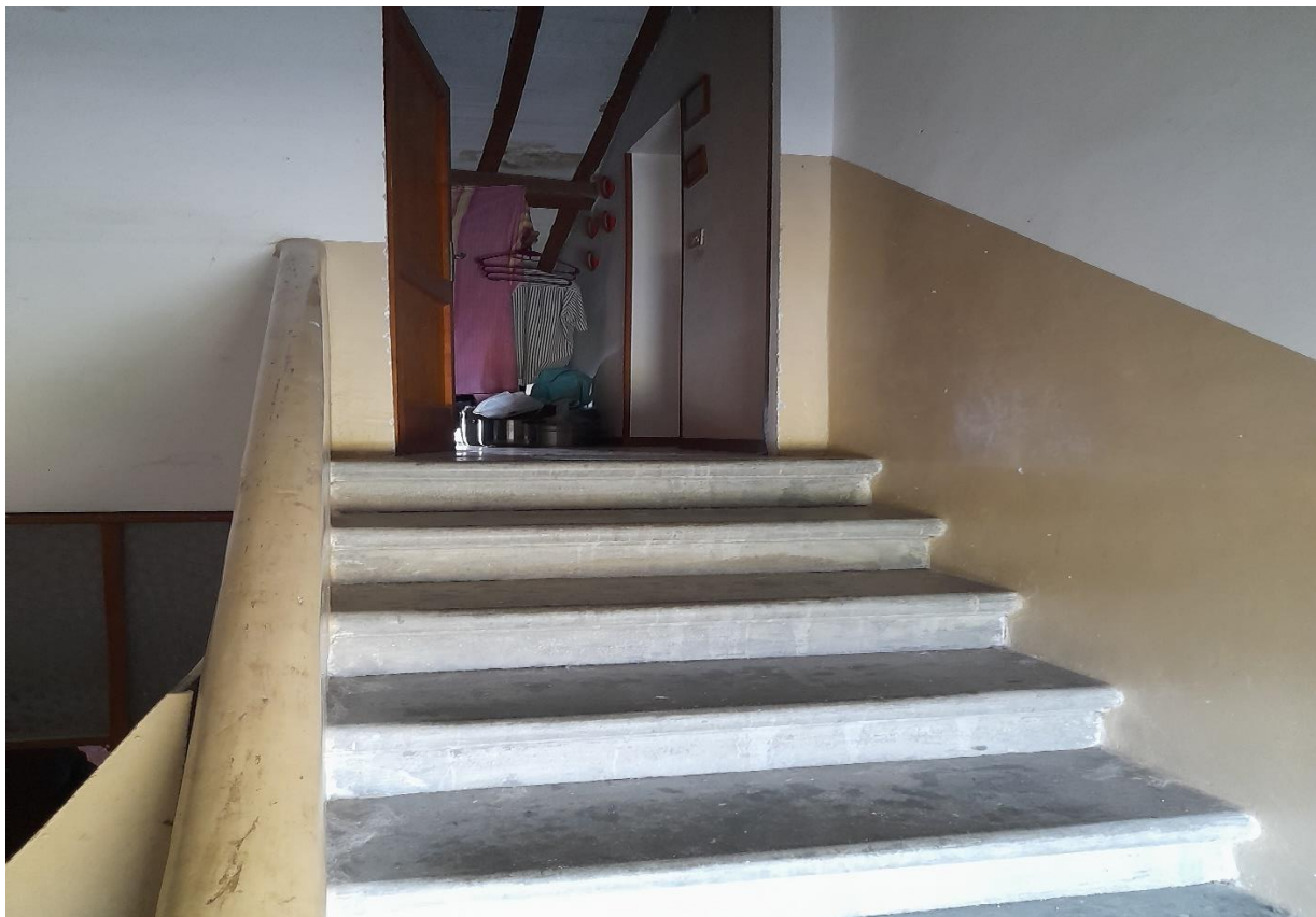
Vano scala P. 3° soffitta
