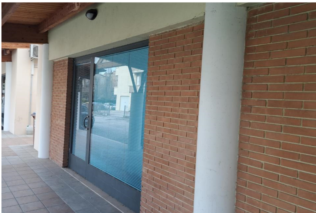
Foto 2 - Esterno, Prospetto Nord
