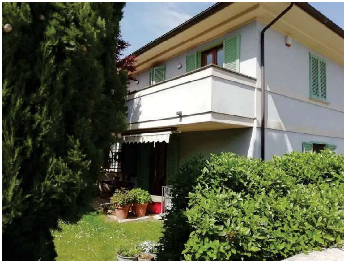
Foto n. 3 – Vista d'insieme dalla corte interna privata (particella 1844)
