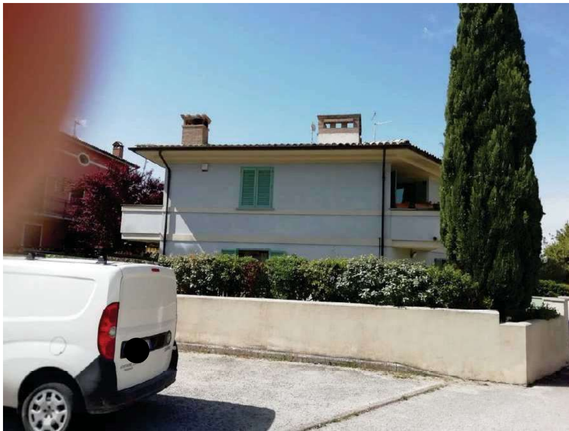
Foto n. 1 – Vista d'insieme del prospetto laterale del fabbricato e della corte (particella 1844)
