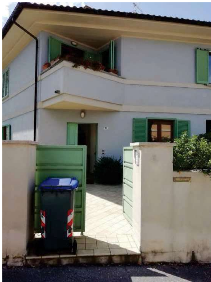
Foto n. 2 – Vista del prospetto d'ingresso della proprietà su corte privata, da Via Mancinelli
