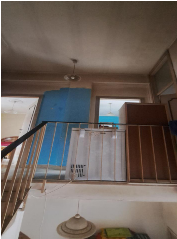
Corridoio al Piano Primo
